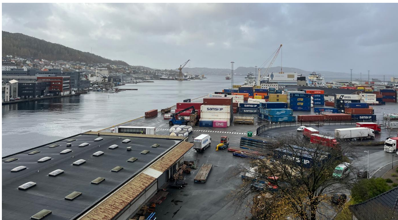
Figur 2-1: Containerhavnen på Dokken med næringsbygg på Indre Laksevåg til venstre. Kranen ved verftsområdet på Laksevåg i bakgrunnen. Foto: Norconsult.
