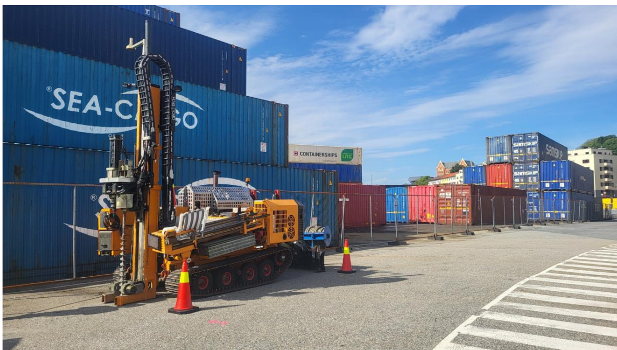
Figur 3-22 Foto av borerigg på Dokken (Miljøteknisk grunnundersøkelse - Dokken, 2024/2025, Sweco).
