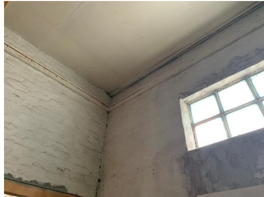
Detalj av interiør, fra det som trolig var kontor/birom.
