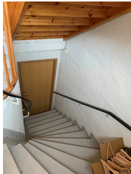
Synlig original trapp, ned til kjeller.
