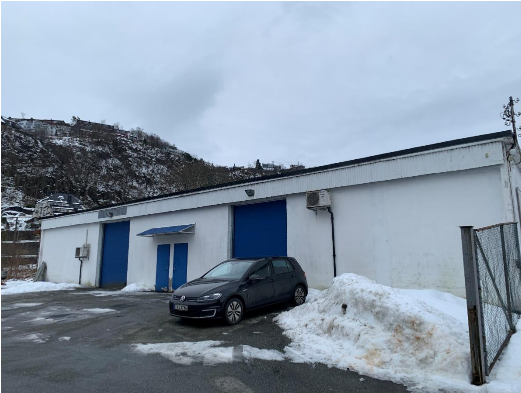
Figur 12 Dagens fasade. De åtte portene er erstattet med 2 porter og den resterende fasaden er støpt igjen. Foto: TAG Arkitekter, Stig T. Thomassen
