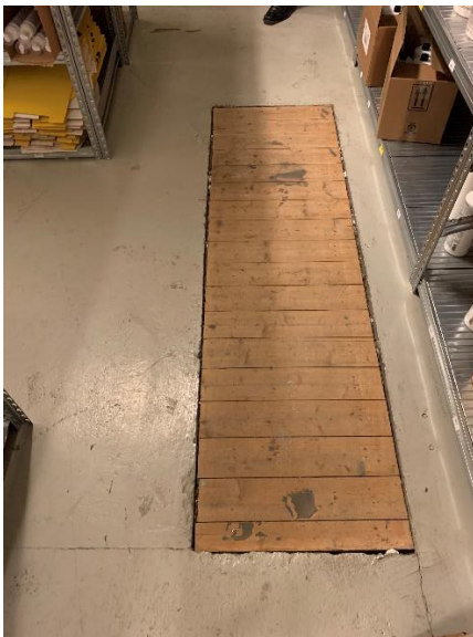
Overdekket trapp til smørebønn for reparasjon av biler. Selve brønnene er støpt igjen.
