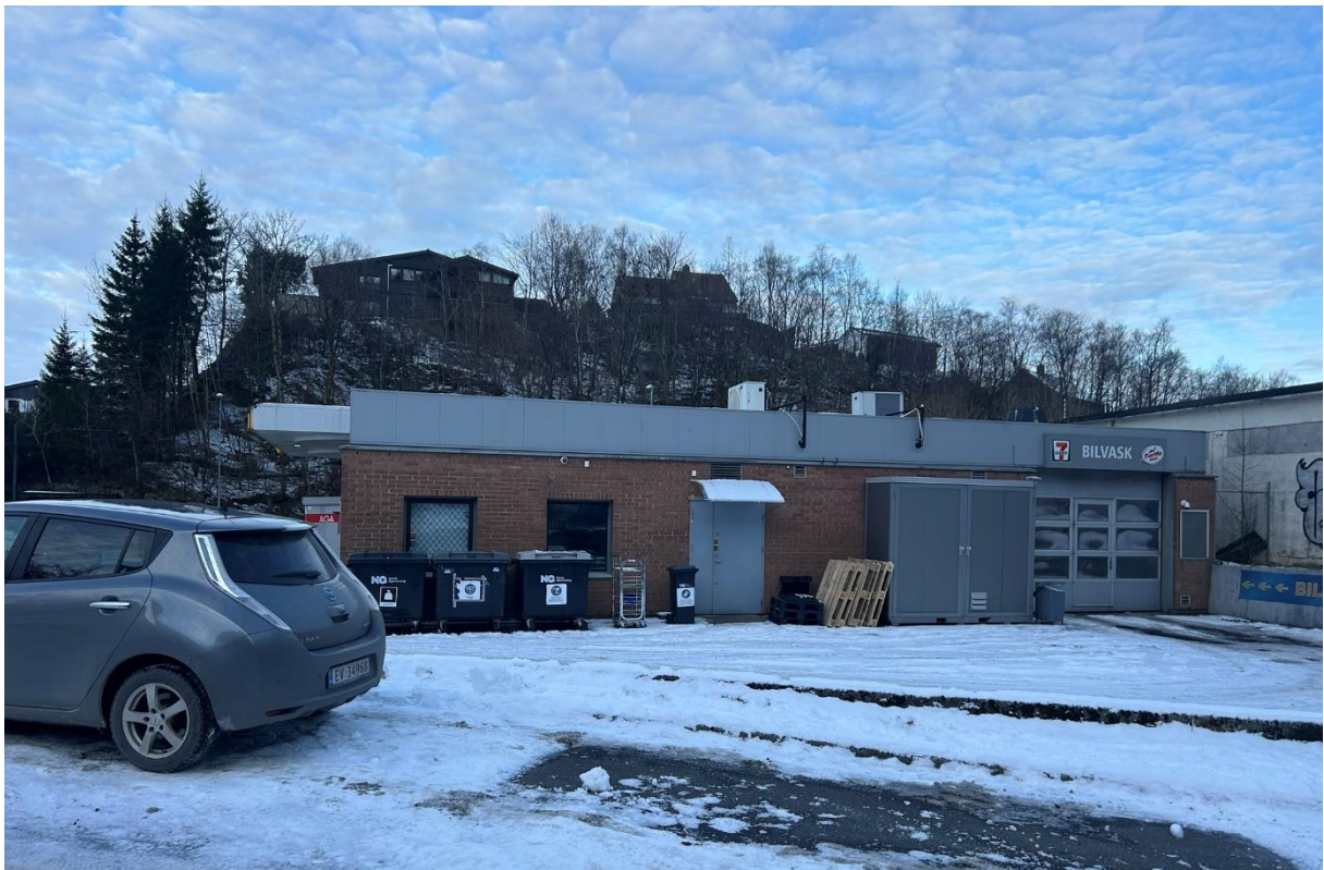
Bensinstasjon sett mot vest. Eldre vaskehall på naboeiendom sees i bildet høyre kant.
