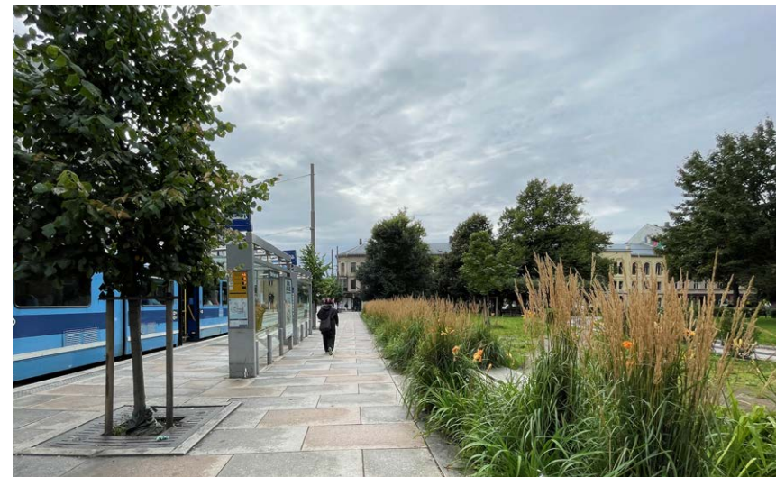
Thorvald Meyers gate Oslo, eksempel på bygate der det er etablert flere regnbed og permeable dekker for lokal håndtering av overvann
