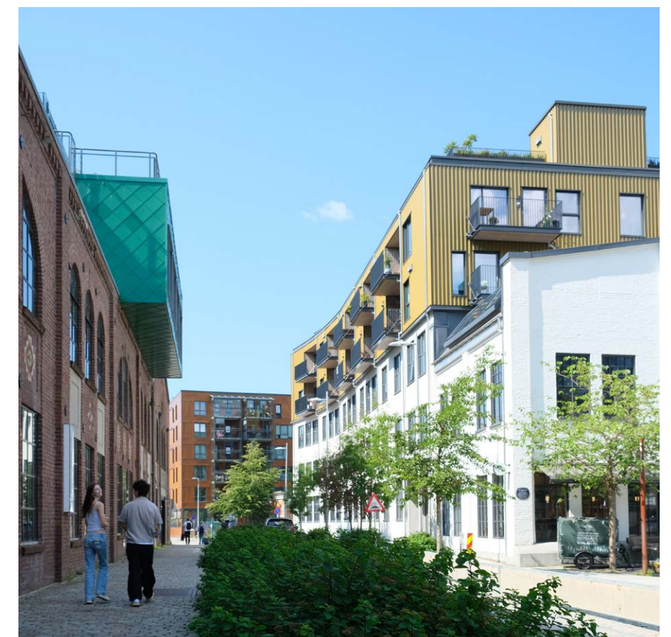
Damsgårdsveien, byromsvegger i gåvennlig gate med blandede funksjoner
