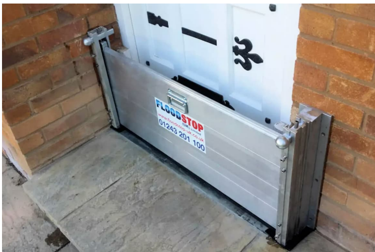
Figur 19 Eksempel på barriere foran åpninger. Hentet fra nettsiden til Flood Stop men tilsvarende produkter kan benyttes. Merk at denne typen barriere vil hindre vann i å komme inn gjennom den aktuelle åpningen (døra)men for at det skal være tett må også de tilstøtende veggene være tette, og gulvet må tåle oppløftkrefter.
