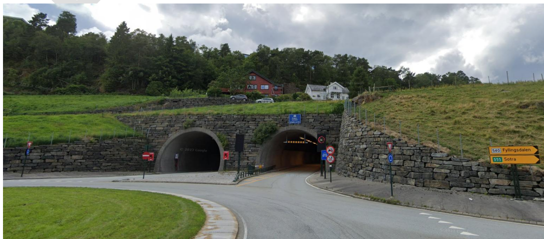
Figur 4-15: Portal til ramper på Ringveg Vest ved Straume, Bergen. To portaler med kort avstand til rundkjøring.
