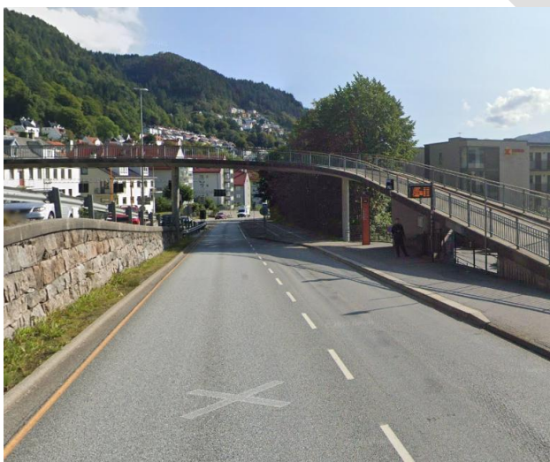
Figur 3-11: Gang- og sykkelbro ved Åsaneveien (google street view, september 2023).
