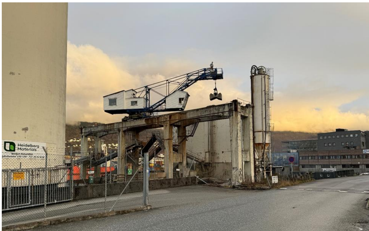
Figur 5-1: Betongfabrikken Heidelberg materials i Damsgårdsveien 155 er et eksempel på en bedrift som har behov for kaifasiliteter. (Fremtiden til denne virksomheten er avhengig av transformasjonsplanene i området. Ingen av bybanealternativene innebærer at denne må flyttes.) Foto: Norconsult.
