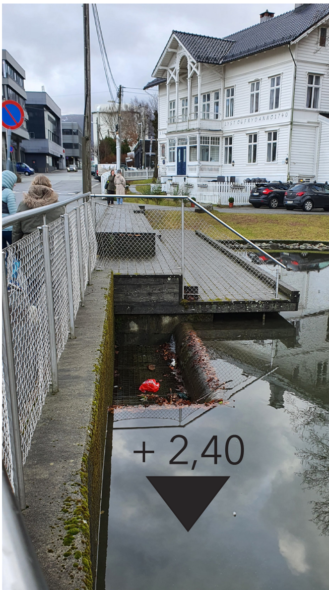
Eksisterende utløp Håsteinarparken. +2.40 illustrerer nivået på vannspeilet. Dykkerledning for videreføring av bekk/vannspeil gjennom Damsgårdsveien vil kreve også arbeider i dette området, og i denne perioden vil vannspeilet ikke være i drift.
