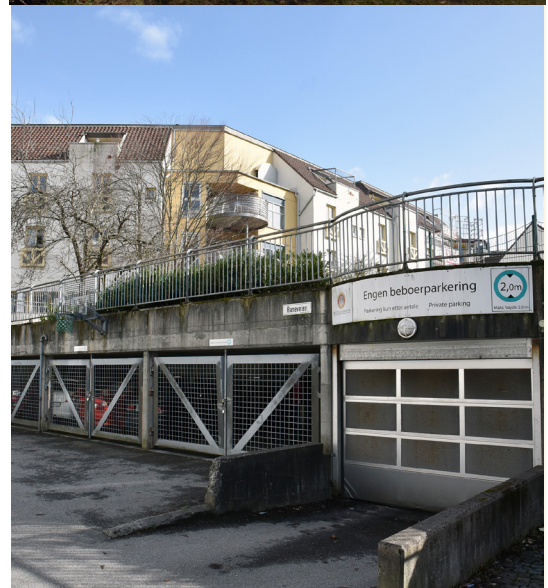
Foto: Nedste bilde, Engen beboerparkering, som er et felles parkeringsanlegg, bildet over viser lekearealet som er etablert på taket til anlegget.
