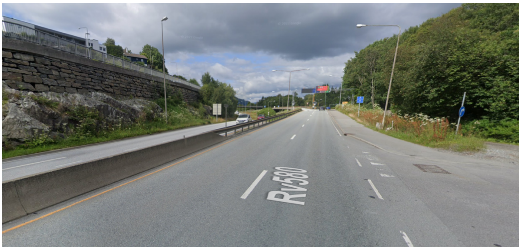
Figur 45: Dagens situasjon. Fanavegen forbi Kalgane, sett fra sør.
