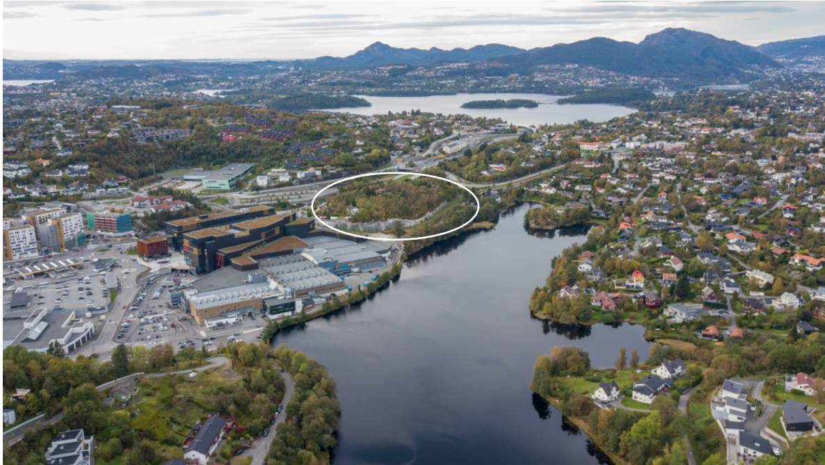
Figur 10 Dronefoto som viser Kalgane sin plassering vest for Apeltunvatnet og nord for Lagunen.
