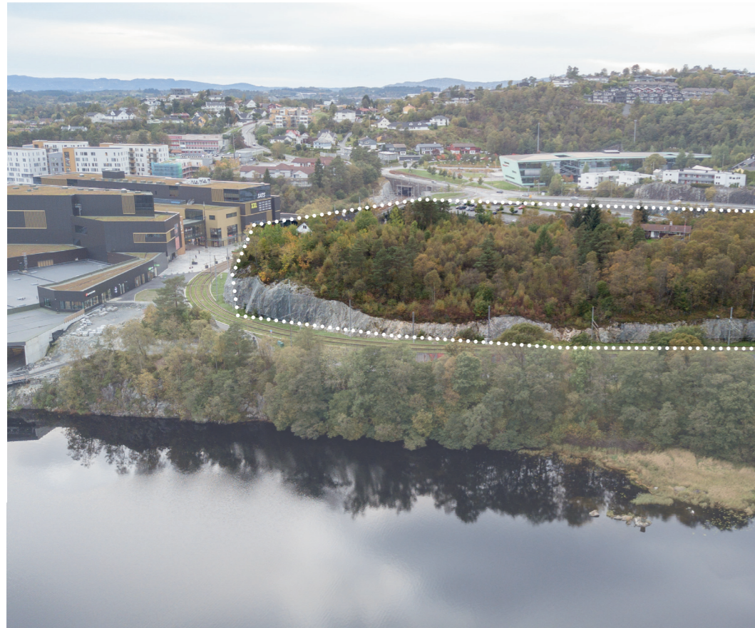
Kalgane sett fra øst med bybanetrasé og Apeltunvatnet nedenfor
