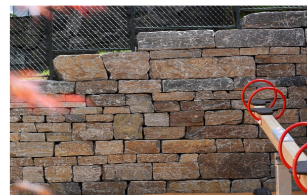
Natursteinsmur Nordnes oppverksstun
