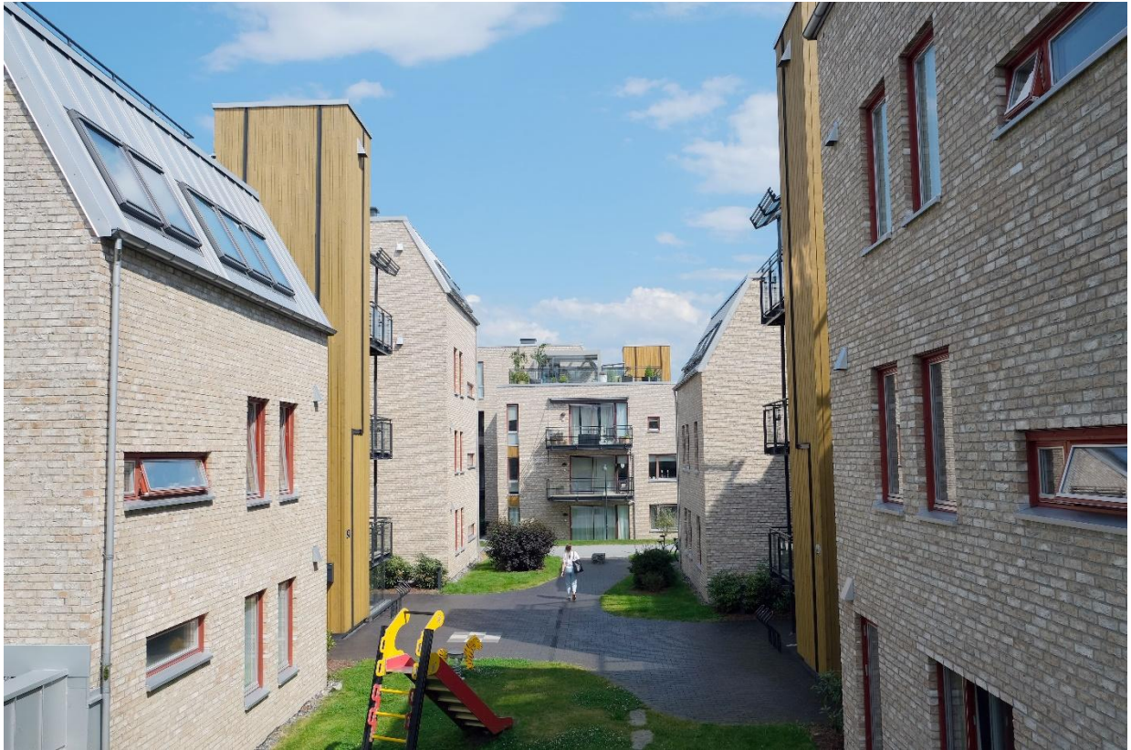
Figur 13 - Dette boligprosjektet på Sandslåsen er et av mange borettslag i Bergen som er etablert med fjernvarme.
