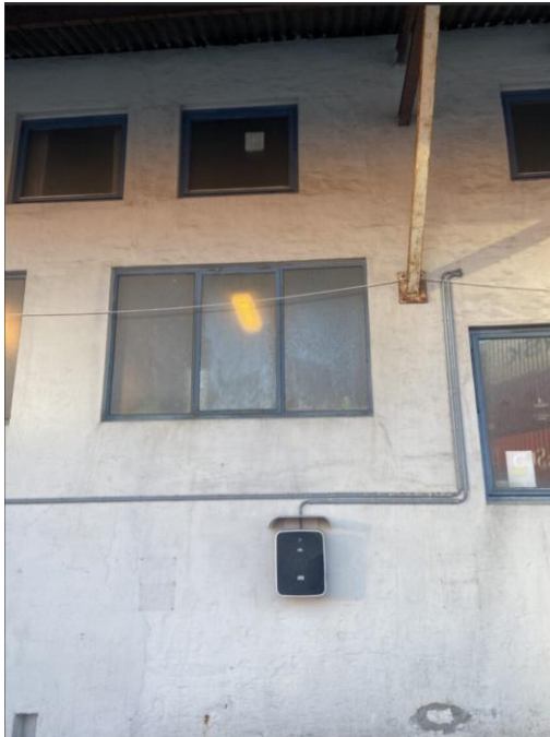
Figur 4-12 Opprinnelig/eldre vindu fasaden mot nord. Fotografi: Asplan Viak, 2025
