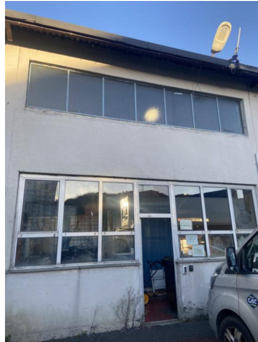
Figur 4-21: Fasaden mot sør
