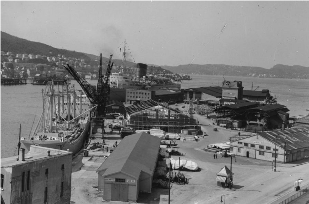
Figur 3-7 Skur 22 under bygging i 1958. Atelier KK for Bergen Havnevesen. Kilde: Marcus, UIB. https://marcus.uib.no/instance/photograph/ubb-kk-n-500-090.html
