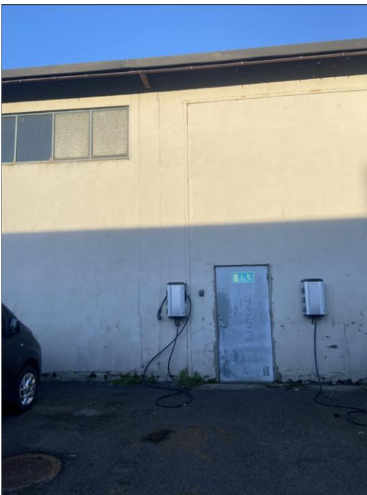
Figur 4-22 Fasaden mot sør
