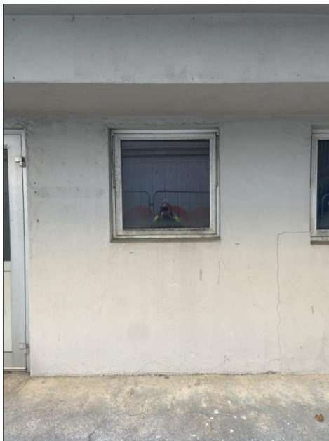
Figur 4-14 Nyere vindu i opprinnelig utsparing. Fasade mot sørøst. Fotografi: Asplan Viak, 2025
