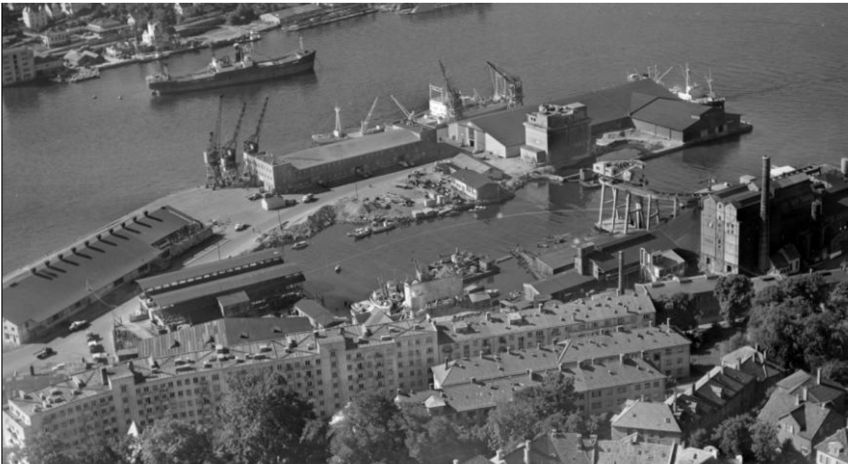
Figur 3-8 Det første kjente bildet av det nyoppførte Skur 22 1958. Kilde: Marcus UiB, Widerøe's Flyveselskap A/S [Torborg Nedreaas gate, Jekteviken] - Marcus
