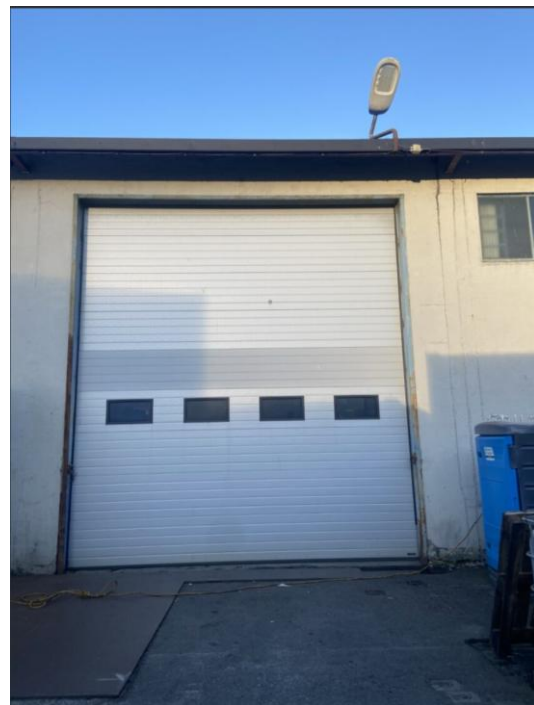
Figur 4-23 Fasaden mot sør
