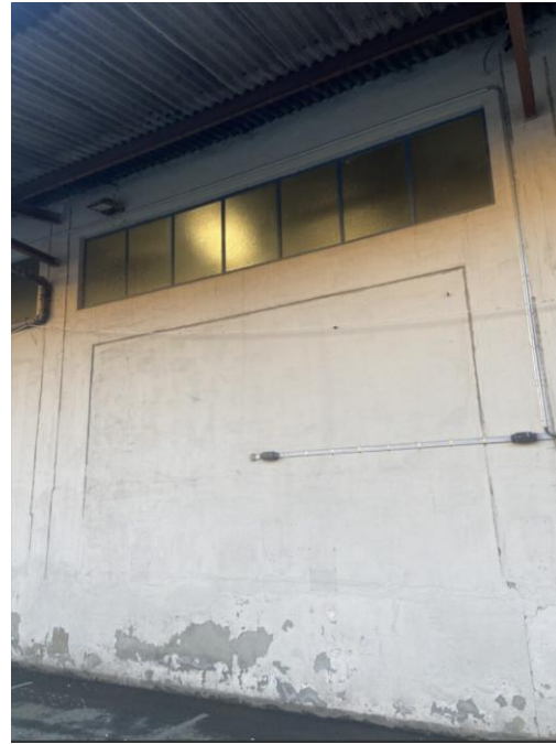
Figur 4-13 Opprinnelig/eldre vindusbånd på fasaden mot nordøst. Gjenmurt tidligere lysåpning. Fotografi: Asplan Viak, 2025
