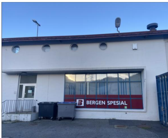
Figur 4-5 Fasade mot sør med opprinnelige/eldre runde vinduer. Fotograf: Asplan Viak, 2025
