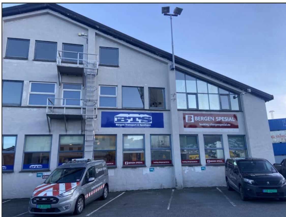
Figur 4-7 Fasade mot vest. Forskjellige vindustyper i fasaden. En av de opprinnelige lysutsparingene er beholdt i fasaden. Fotograf: Asplan Viak, 2025
