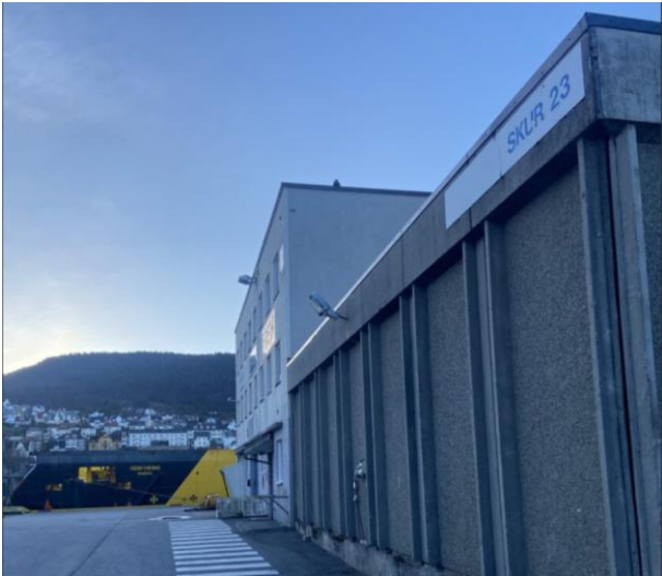
Figur 40 Hjørnet på tilbygget fra 1971. Fasade mot sør. Fotografi: Asplan Viak, 2025
