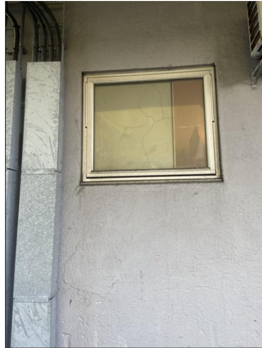
Figur 33 Nyere innsatt i 1. etasje av skuret i vestfasaden. Årstall ukjent. Fotografi: Asplan Viak, 2025
