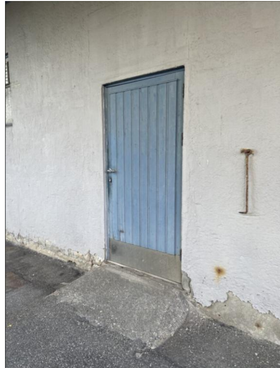
Figur 37 Opprinnelige dør i 1. etasje på skuret i vestfasaden Fotografi: Asplan Viak, 2025
