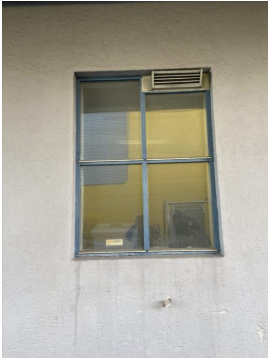
Figur 32 Opprinnelige vindu i 1. etasje på skuret i vestfasaden. Fotografi: Asplan Viak, 2025
