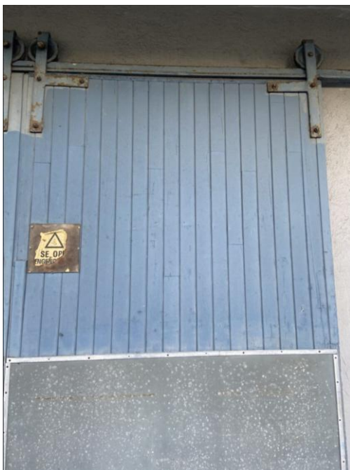
Figur 34 Eldre eller opprinnelig port i vestfasaden. Fotografi: Asplan Viak, 2025
