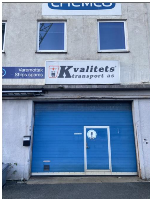
Figur 38 Nyere port i 1 etasje på sidebygget i nordfasaden Fotografi: Asplan Viak, 2025
