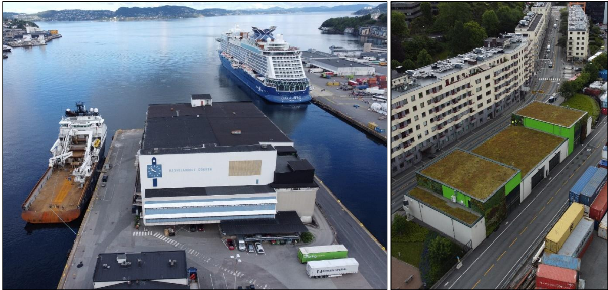
Figur 5-4 Havnelageret (t. v.), AØF L3, er hekkeplass for 3 par sildemåker. Alle parene hekket på det svarte taket på avsatsen under klokken. Dokkeboder (t. h.), AØF L6, med Sedum-tak har fire hekkende par med fiskemåker. Foto: Arild Breistøl.
