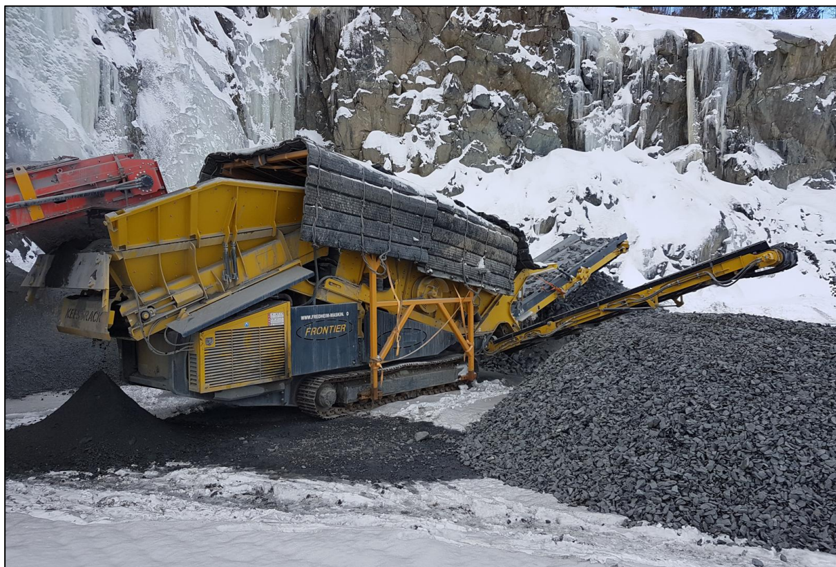
Figur 4-12: Bilde av sikteverk med støytiltak i form av stålramme med sprengningsmatter.
