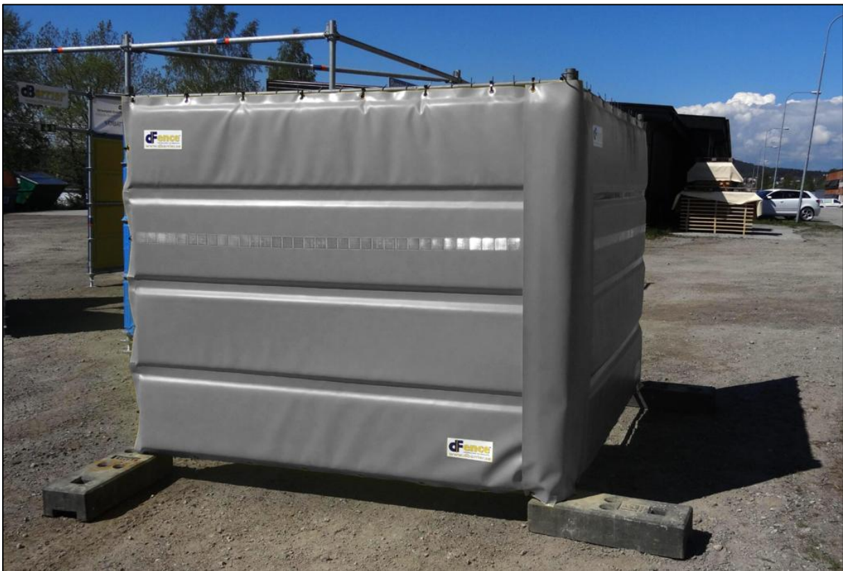
Figur 4-11: Bilde av byggegjerde som er kledd med støydempende matter. Bildet er hentet fra Zilento AS sine hjemmesider.
