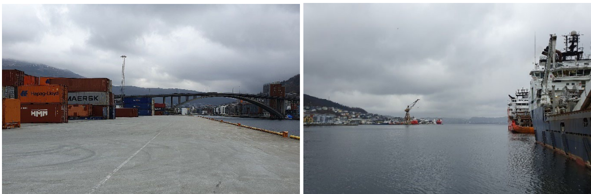
Figur 3.8 T.v. Puddefjordsbroen spenner over fjorden like sørøst for Dokken. Broen er et kjent landemerke i denne delen av byen. T.h. vises utsikten utover fjorden. Skip til kai langs Dokken til høyre i bildet. Til venstre sees kranen på Laksevåg Verft, et landemerke i bydelen. Foto: Nina Rieck, Asplan Viak.
