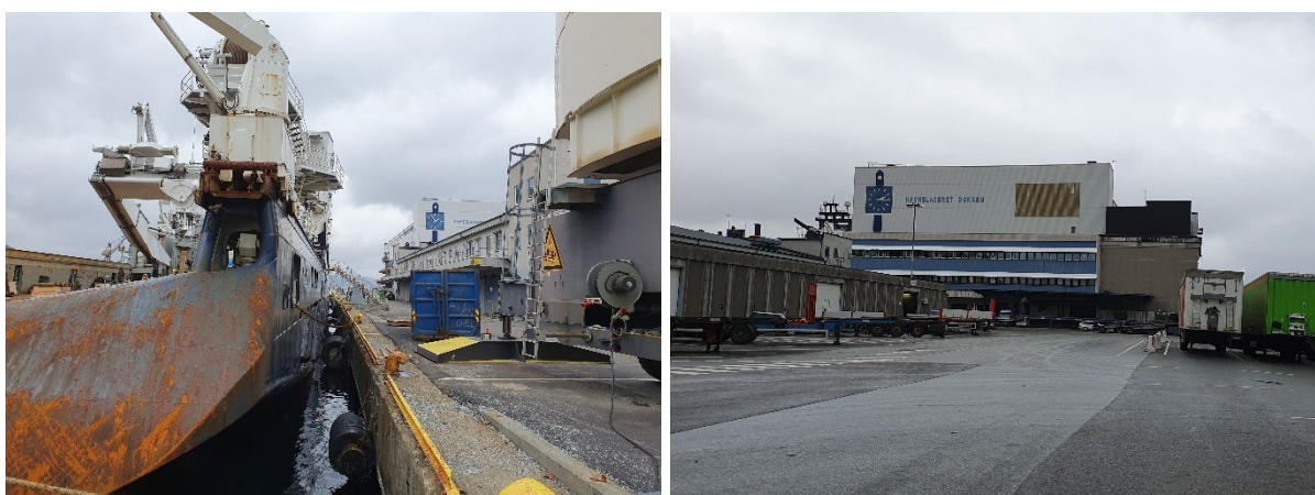
Figur 3.7 T.v. Store skip ved havn langs Havnelageret. T.h. Havnelageret er en dominerende bygning på kaien. Et av skurene til venstre i bildet. Foto: Nina Rieck, Asplan Viak.
