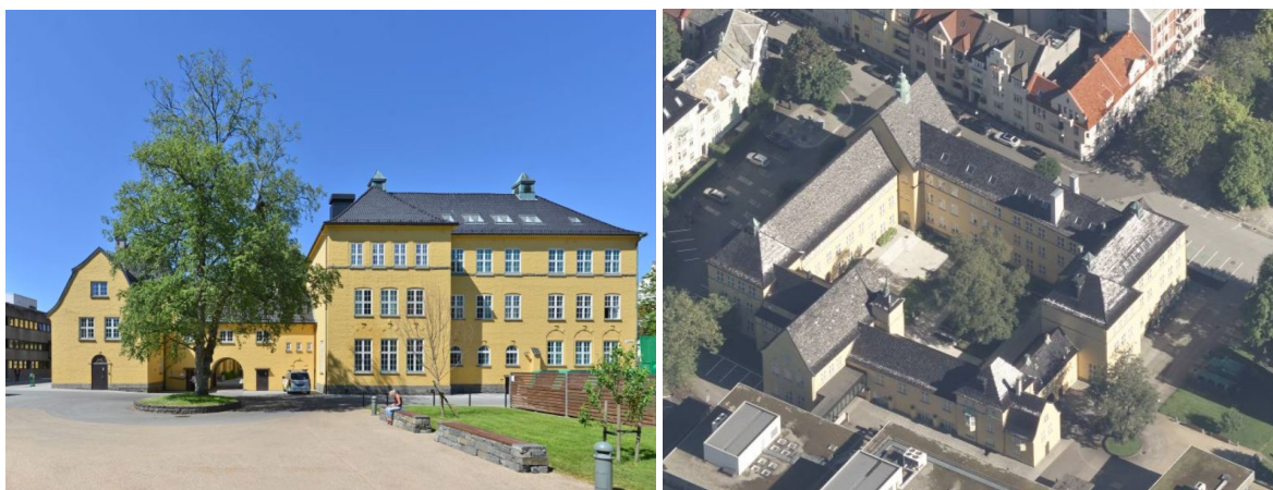
Figur 3-22 T.v. Sydneshaugen skole i 2018. Fotograf: Thomas Vindal Rundhovde. T.h.: skråfoto av Sydneshaugen skole i 2024. Kilde: 1881 Kart
