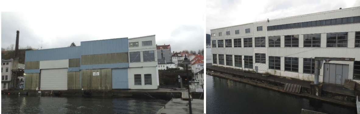
Figur 28 Fasaden mot sjø til venstre og fasade mot tørrdokken til høyre
