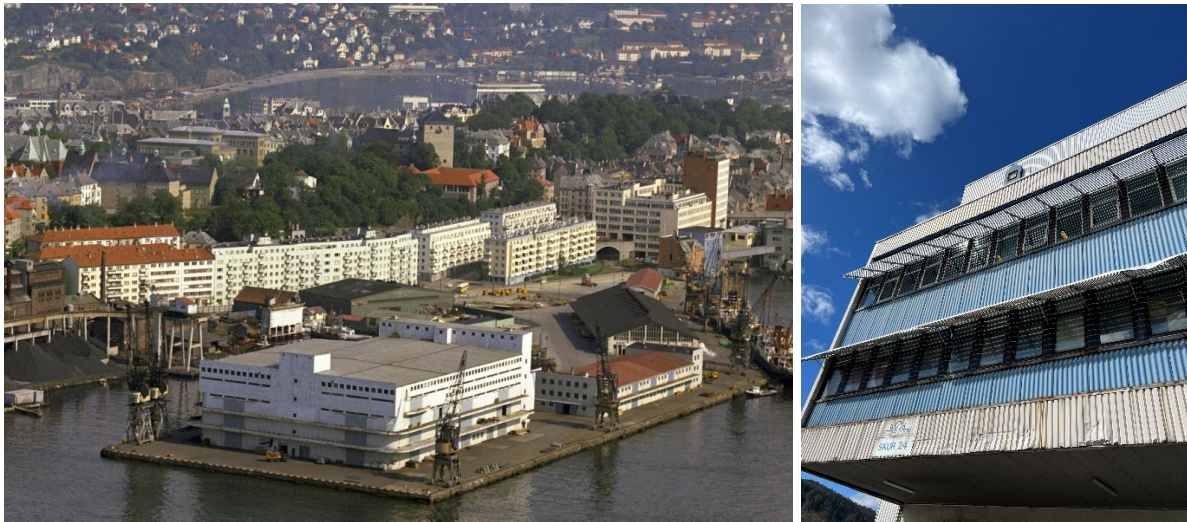
Figur 3-14 Havnelageret i front med Skur 22 og 23 i bakkant til høyre. Bildet til venstre er tatt i 1962. Bildet til høyre viser fasadedetaljer av Havnelageret tatt våren 2024.
