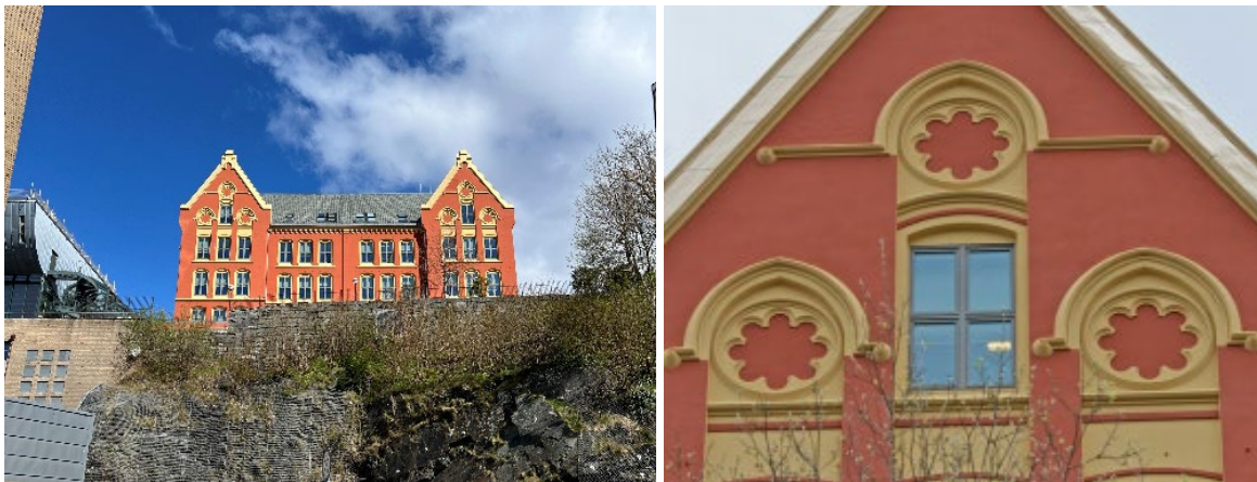
Figur 3-23 T.v. Dragefjellet skole sett fra Dokken-området, og t.h. fasadedetaljer.
