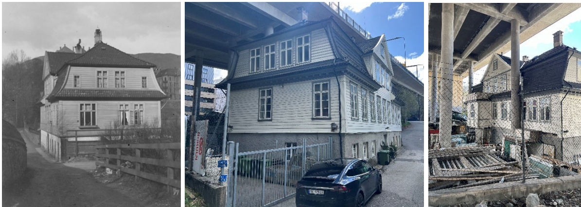
Figur 3-11 T.v.: Monclairhuset i 1918, i midten og til høyre viser huset våren 2024. Kilde: UiB og Asplan Viak.
