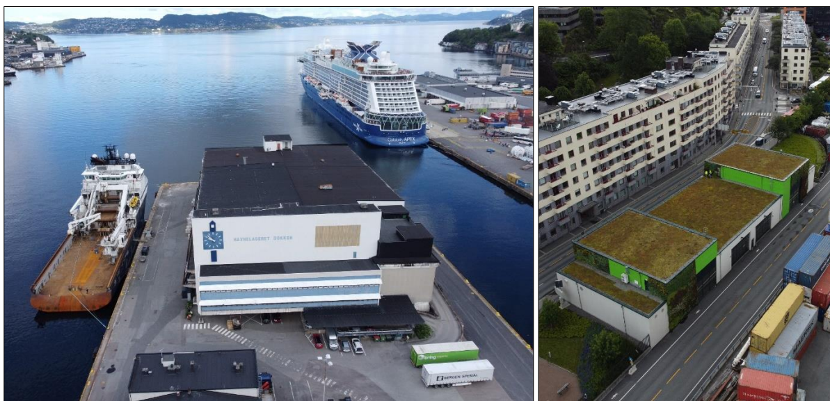
Figur 2-8 Havnelageret (t. v.), AØF L3, er hekkeplass for 3 par sildemåker. Alle parene hekket på det svarte taket på avstatsen under klokken. Dokkeboder (t. h.), AØF L6, med Sedum-tak har fire hekkende par med fiskemåker. Foto: Arild Breistøl.
