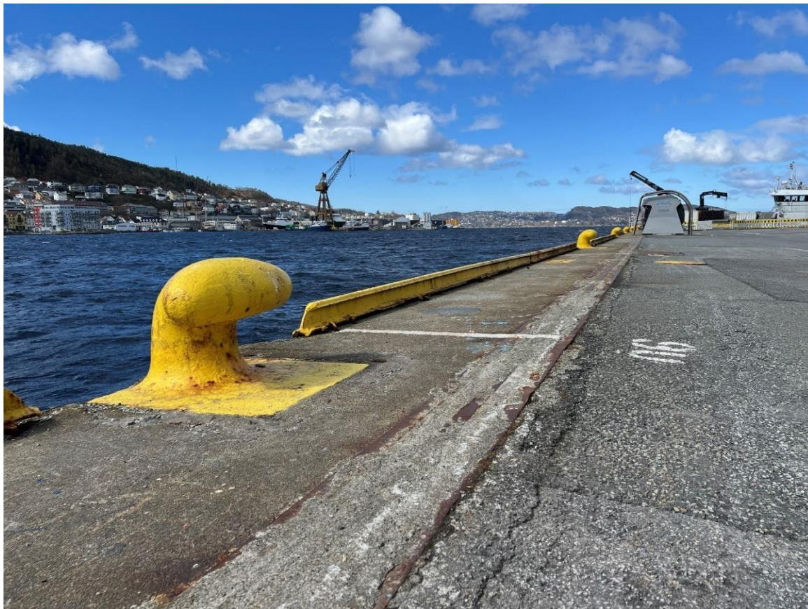
Figur 8 Eksisterende kaikant på ca. kote +2
