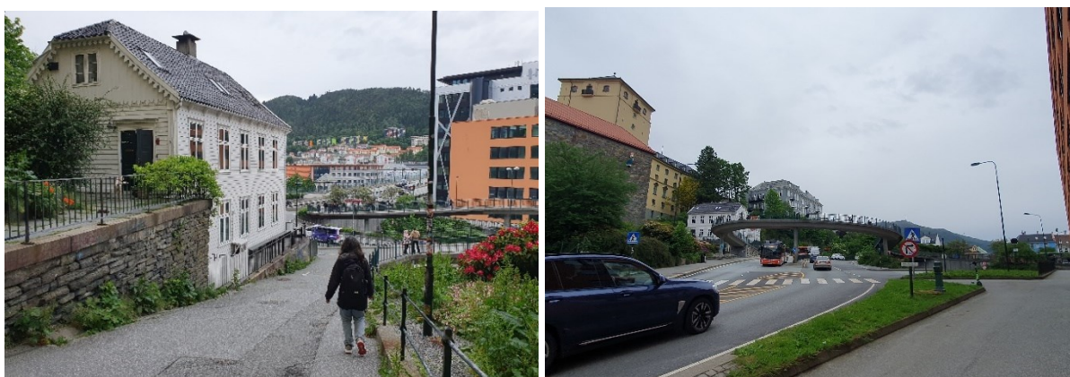
Forbindelse i Møhlenprisbakken og sykkelbroen over Puddefjordsbroen sett fra Torborg Nedreaas gate
