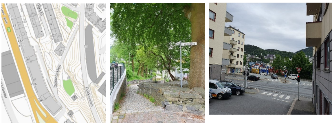
Figur 3-1 Oversiktskart over forbindelser i midtre del av Nygårdshøyden, Dokkebakken er opparbeidet med brostein og natursteins-mur, krysset med Torborg Nedreaas gate
