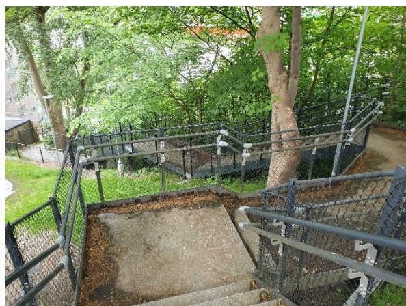
Trapp ned til Torborg Nedreaas gate ved barnehagen.
