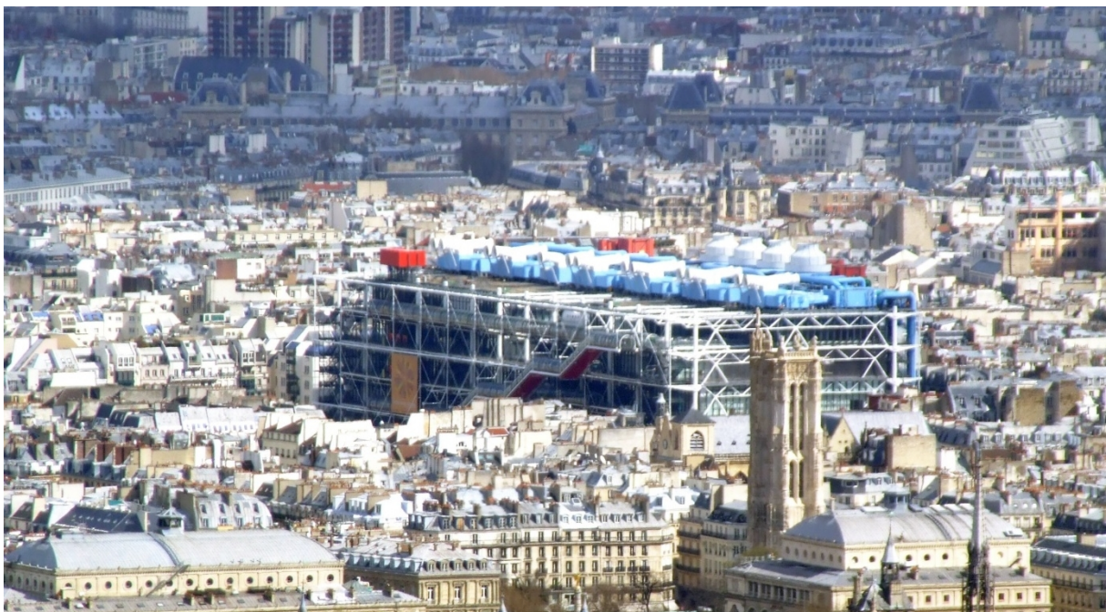
Figur 4-13: Pompidou-senteret i Paris. Bygget skiller seg både i form og skala fra omkringliggende kvartalsstruktur. (Alf van Beem, CC0, via Wikimedia Commons, https://commons.wikimedia.org/wiki/File:Centre_Pompidou,_seen_from_Tour_Montparnasse.jpg )
