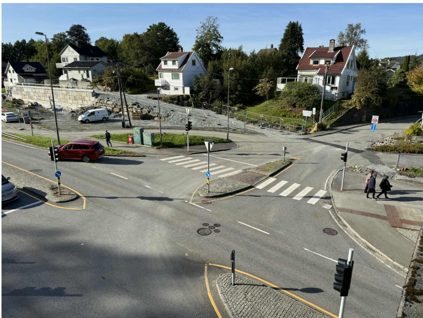
Figur 3. Trafikale problemstillinger knyttet til kapasitet og fremkommelighet for biltrafikken i krysset Fanavegen/Tors veg inngår i trafikkanalysen for planen.
