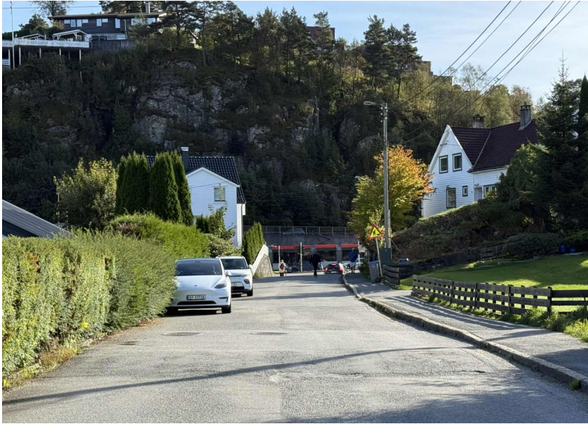
Figur 16. Tors veg har i dag kun fortau langs vestsiden av gaten. Planforslaget vil bidra til forbedret mobilitet for gående ved å legge til rette for fortau på østsiden av gaten, og etablere flere nye gangforbindelser gjennom planområdet til Odins veg og sykkelstamvegen.
