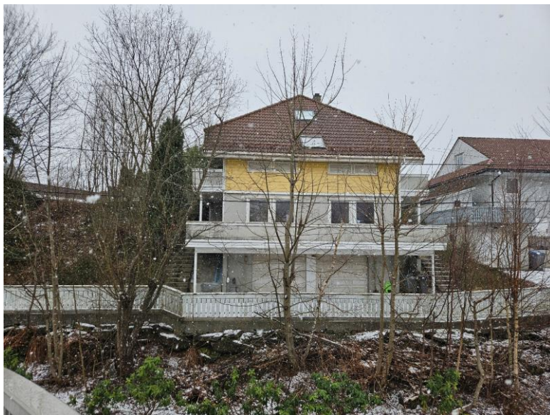
Figur 50 Eksisterende bolighus på gnr.1461 sett fra sørvest.
