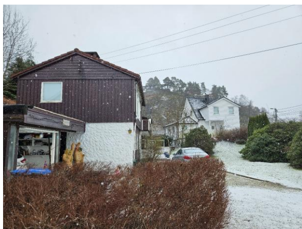
Figur 36 Fasade mot nord (venstre) fasade mot sør (høyre).
