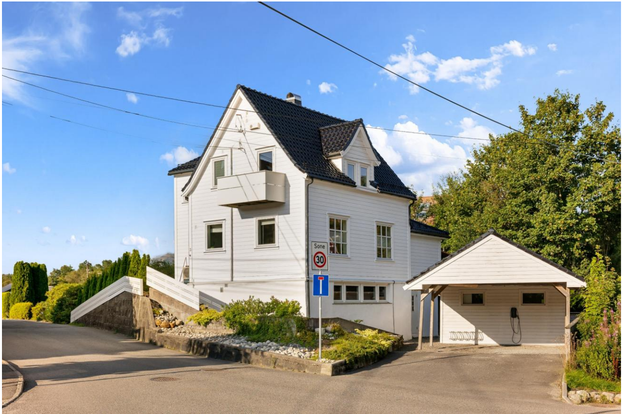
Figur 18 Eksisterende bolighus fra 1920 på Tors veg 3 (Truls Bakken).
