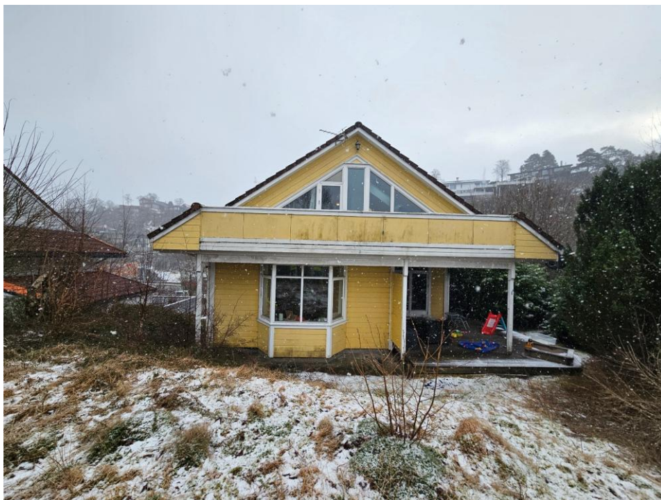
Figur 52 Fasade sett fra sørøst med synlig vinkelutforming i vinduer, takform og takutstikk.
