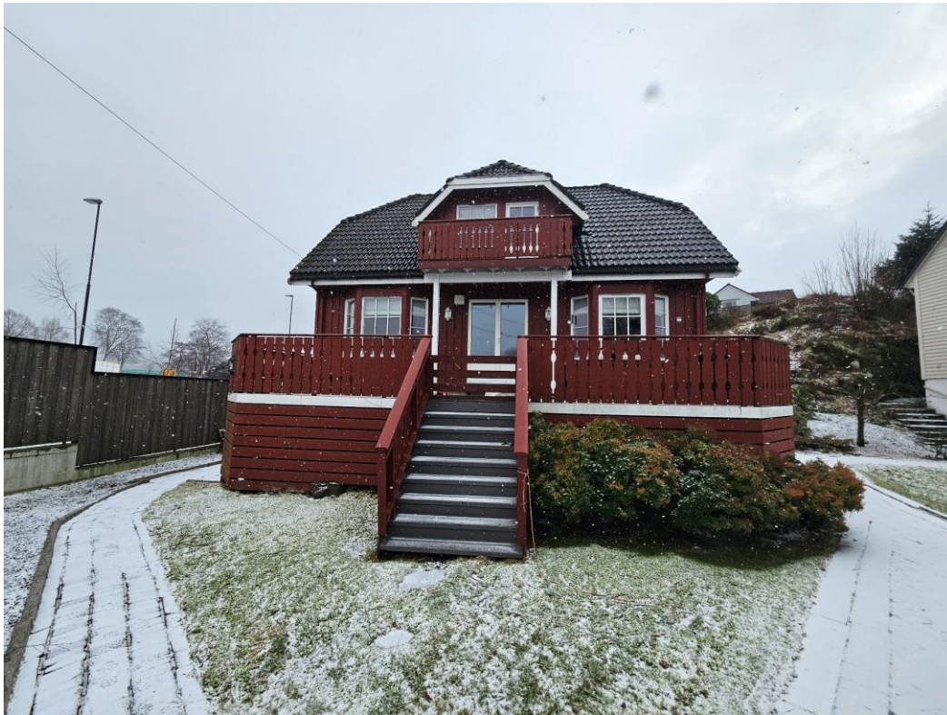
Figur 45 Eksisterende enebolig på gnr.1534.
