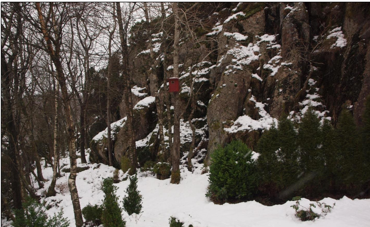
Figur 1-13. Skråning nordvest i tomten. Overflaten har lite løst materiale.
