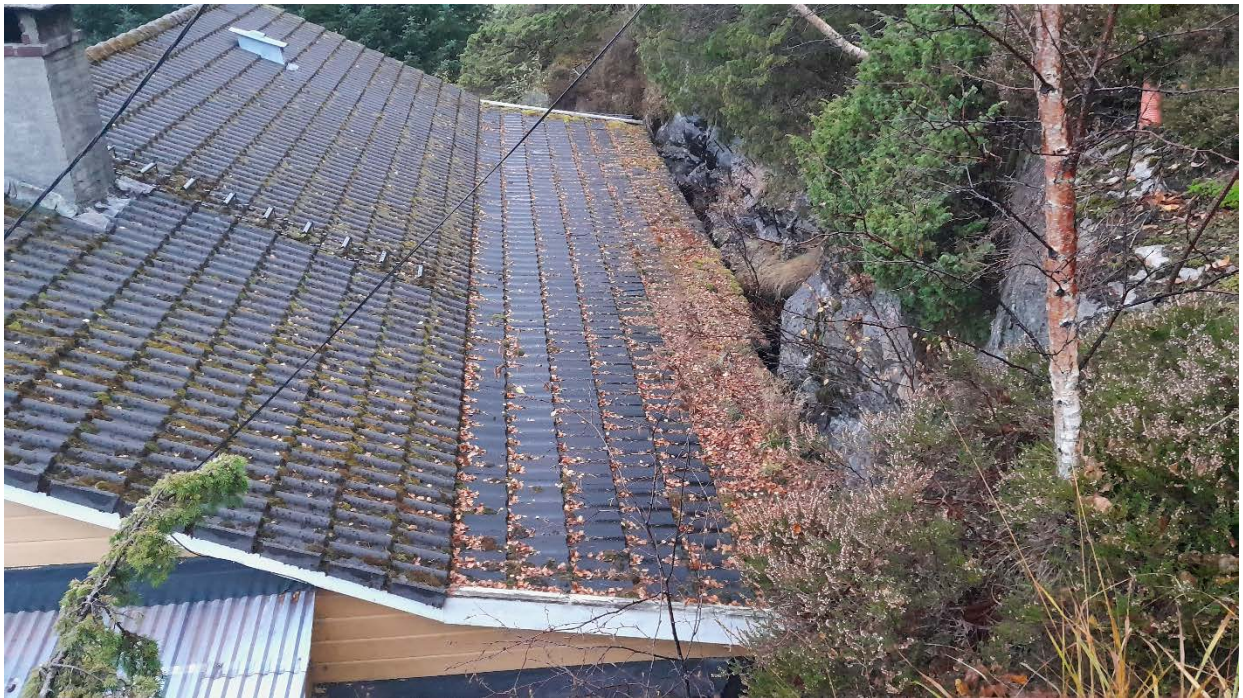
Tak/fasade mot bergvegg mot nord
