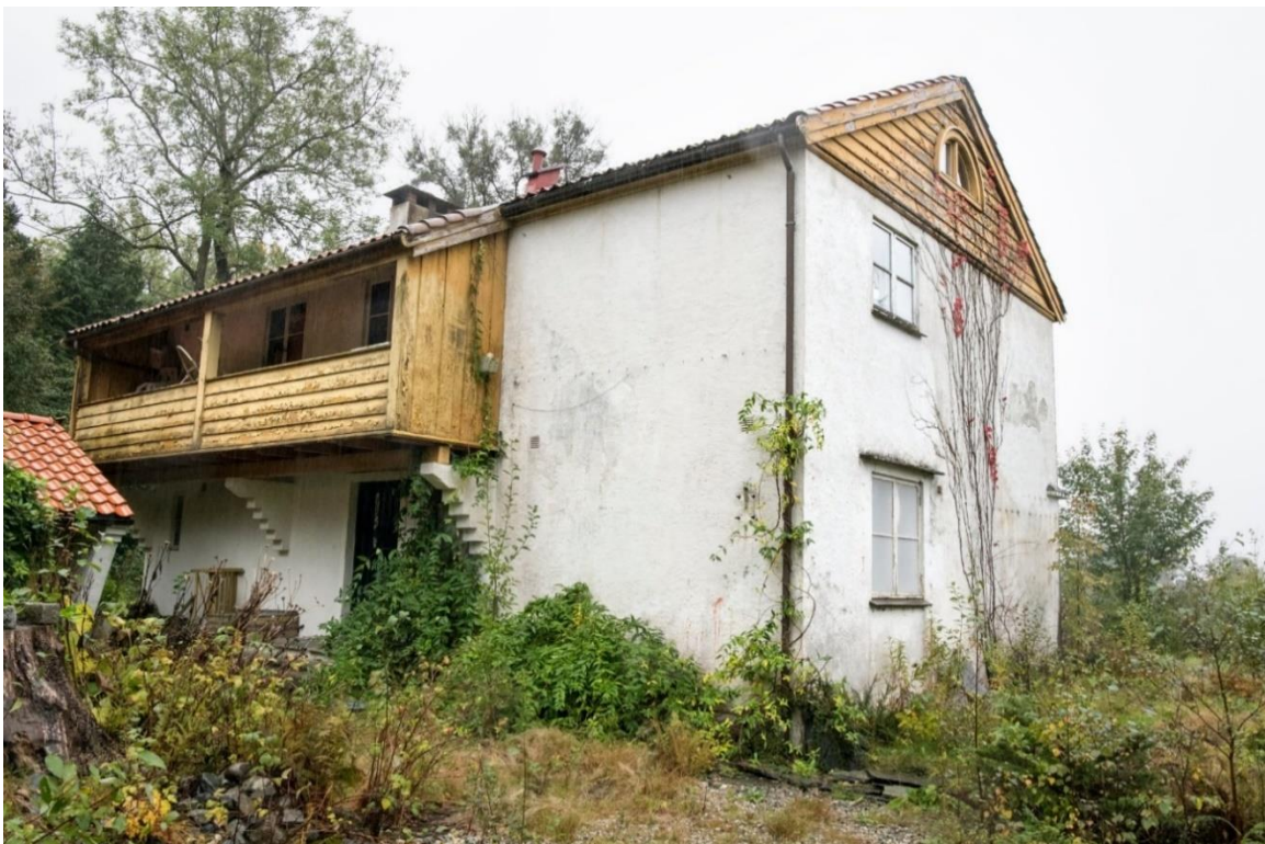
Fasade mot Nordvest og Nordøst september 2021
