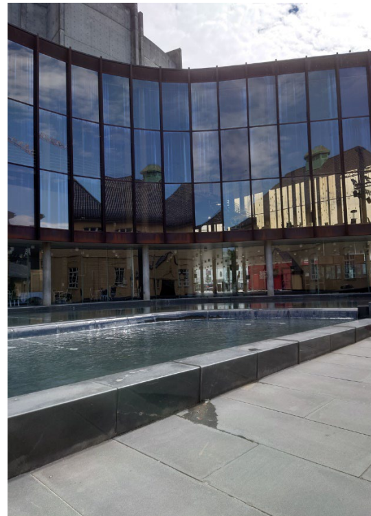
Figur 3-4 Grieghallen sett fra smauet mellom Nina Griegs gate og Lars Hilles gate.
