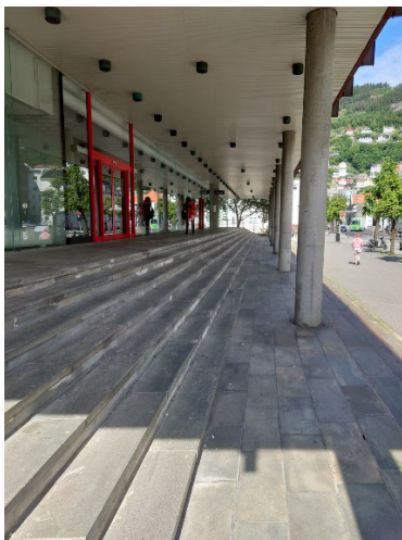
Figur 3-11 Langs bygget mot Strømgaten er det overbygd gangareal. Her er det trapper ned til fortauet langs Strømgaten.
