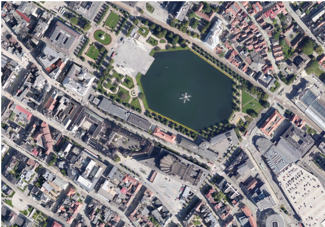
Figur 3-1 - Luftfoto fra planområdet. Nord for området ser vi Lille Lungegårdsvann med tilhørende parkanlegg, øst for planområdet ser vi busstasjonen med tilhørende parkeringsplasser. (Kilde: Ambita.no)
