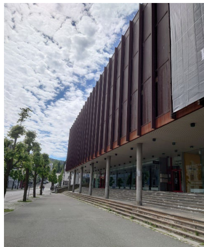
Figur 3-12 Bilde viser overgangen mellom fortau langs Strømgaten og overbygd trapp.
