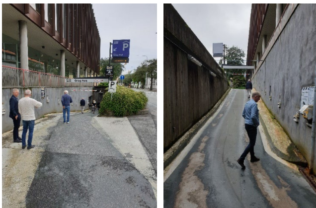
Figur 20 Eksisterende rampe i Lars Hilles gate (fungerer i dag som nedkjøring til Grieg-park-anlegget)
