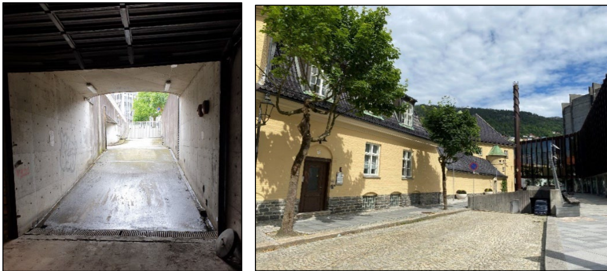
Figur 19 Eksisterende rampe i Nina Griegs gate (i dag benyttes denne i mindre grad)
