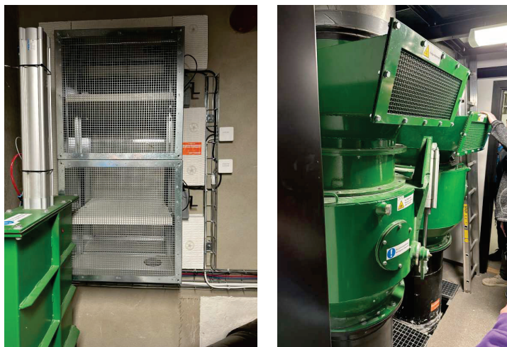
Bilder fra befaring til Vestlandshuset, august 2024. Krav til tilgang til luft er 1 m2 fri areal.
