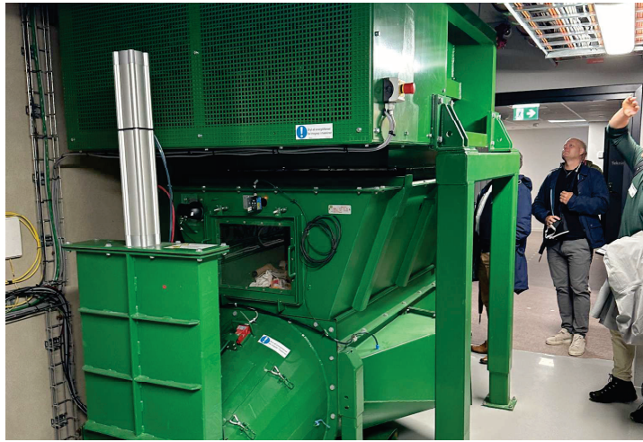
Bilder fra befaring til Vestlandshuset, august 2024.
