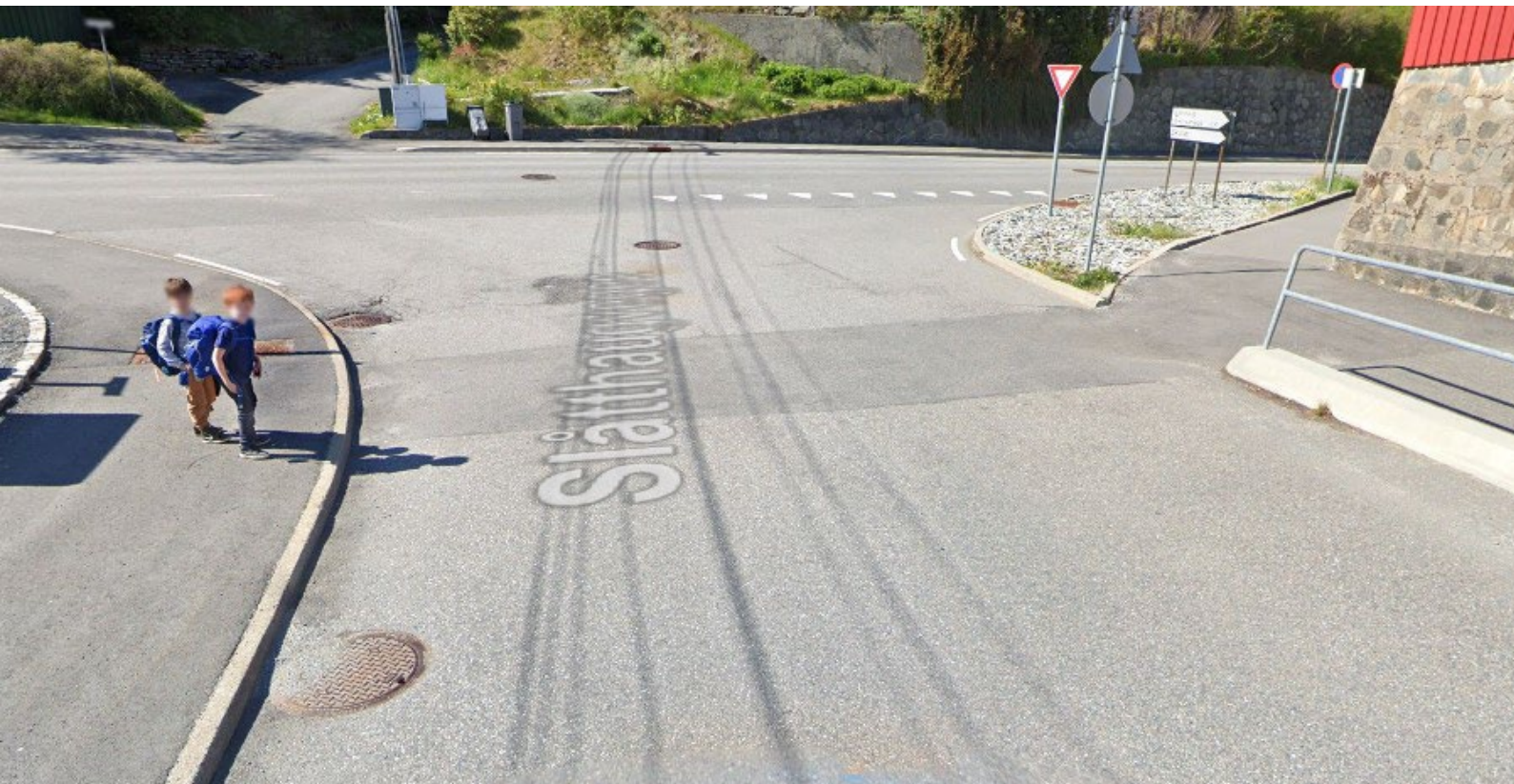
Figur 12: Kjørebane hvor det burde vært etablert overgangsfelt. Delvis tilrettelagt med åpning av rekkverk på ene siden. Apeltunvegen x Slåtthaugvegen (Google Maps).
