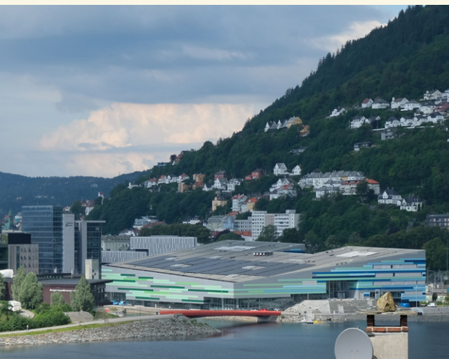
Foto: ADO arena og Amalie Skram videregående skole har solceller, solfangere og varmepumpe.
