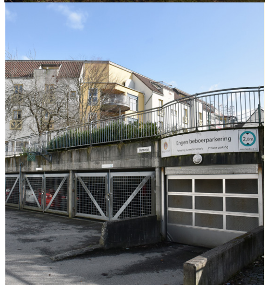
Foto: Nedste bilde, Engen beboerparkering, som er et felles parkeringsanlegg, bildet over viser lekearealet som er etablert på taket til anlegget.
