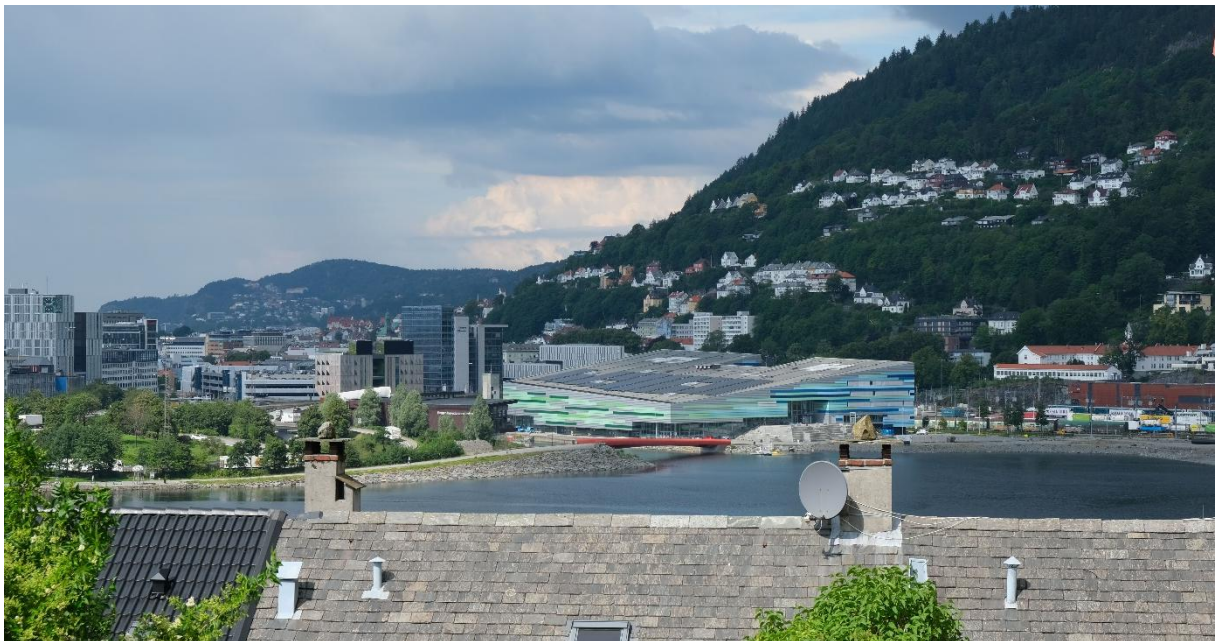
Figur 19 - ADO arena ved Store Lungegårdsvann har både solfangere og solceller på taket.
