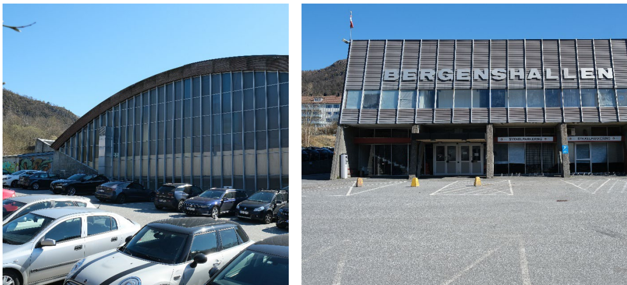
Figur 5-60: Bevaringsverdige Bergenshallen. Foto: Christine Hvidsten, Bergen kommune (2023)
