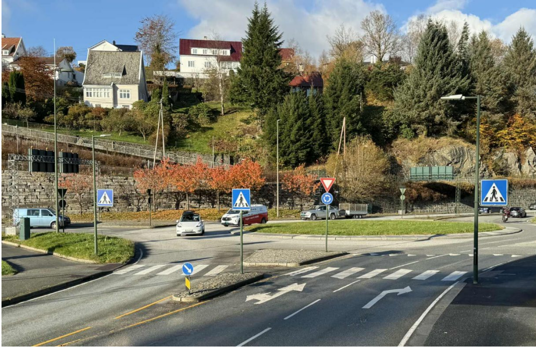
Figur 17. Det har inntruffet flere fotgjengerulykker i gangfeltene ved Skjoldskiftet. Uavhengig av planforslaget anbefales det å vurdere innsnevring av tilfart fra Apeltunvegen til 1 kjørefelt.
