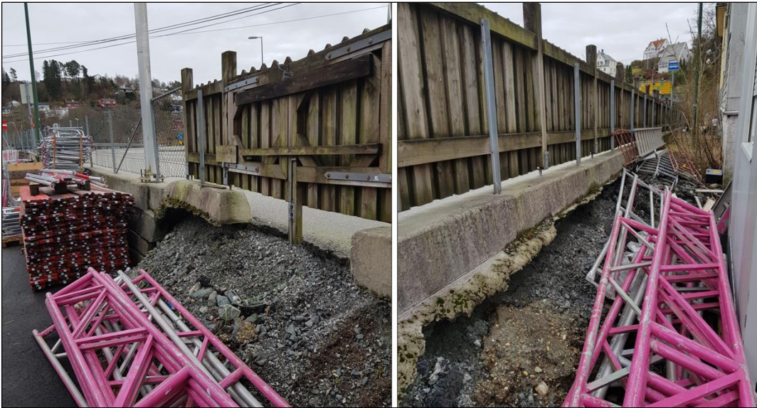
Figur 8: Bilder fra befaring 23.02.2023. Til venstre: bilde tatt i retning mot øst ved fortau v/E39, til høyre: bilde tatt i retning mot vest ved fortau v/E39.
