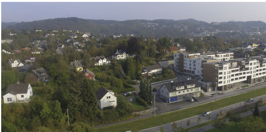
Figur 7-1 Planområdet, Sætervegen 4, byggetrinn 1 og kulturmiljøet Heienberg sett mot sørøst. Foto: Nåbo AS (tidl. Bonava), 2021.
