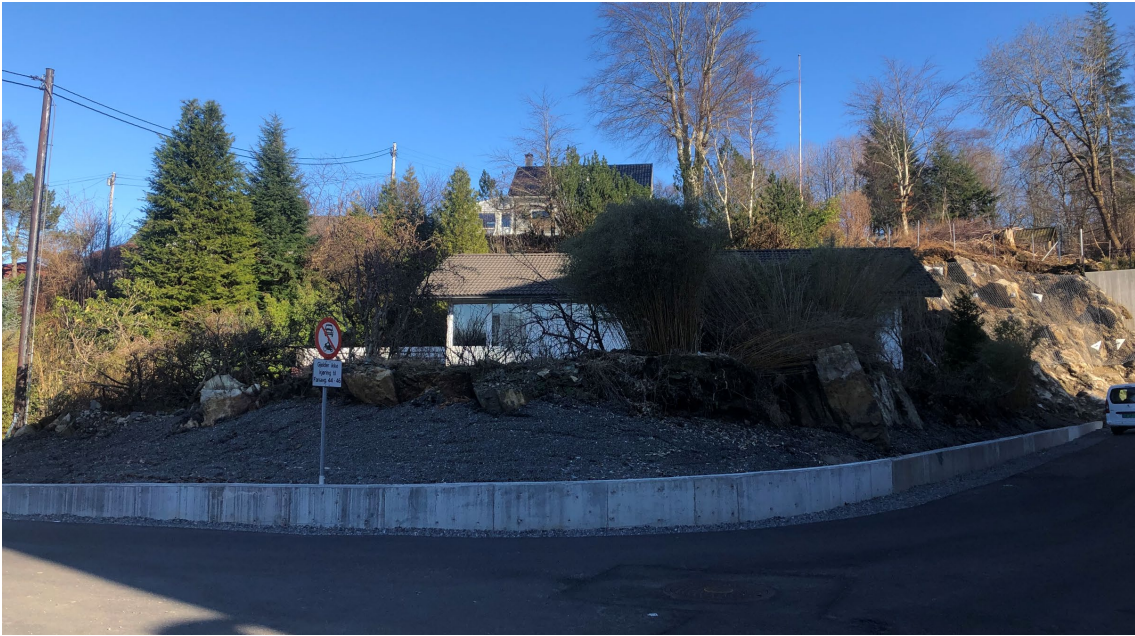
Figur 5-25 Boligen sett fra ny tilkomstvei. Noe av hagebeplantningen er bevart foran boligen. Foto: AKB, Opus.
