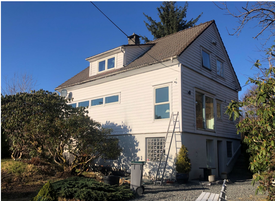
Figur 5-7 Sørvestre fasade. En har endret vinduer fra opprinnelig bygget. Foto: AKB, Opus.
