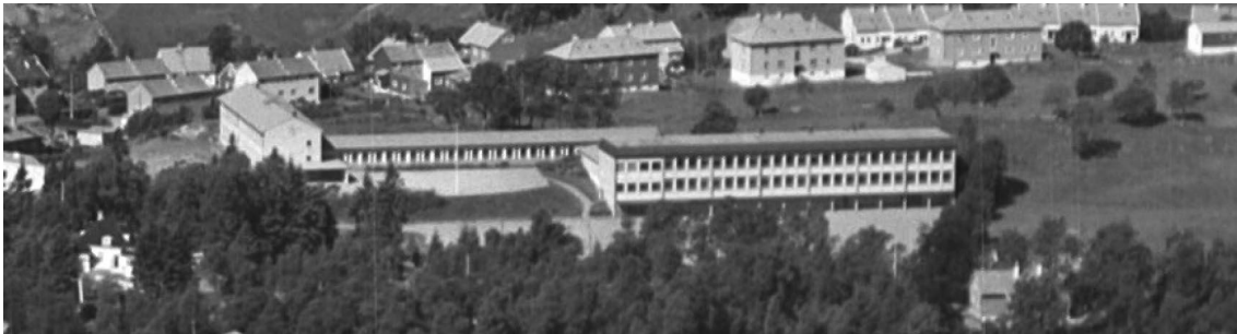
Figur 4-4 Foto av Skjold skole rett etter den ble bygget. Billedsamlingen UBB-W-SH-140882.
