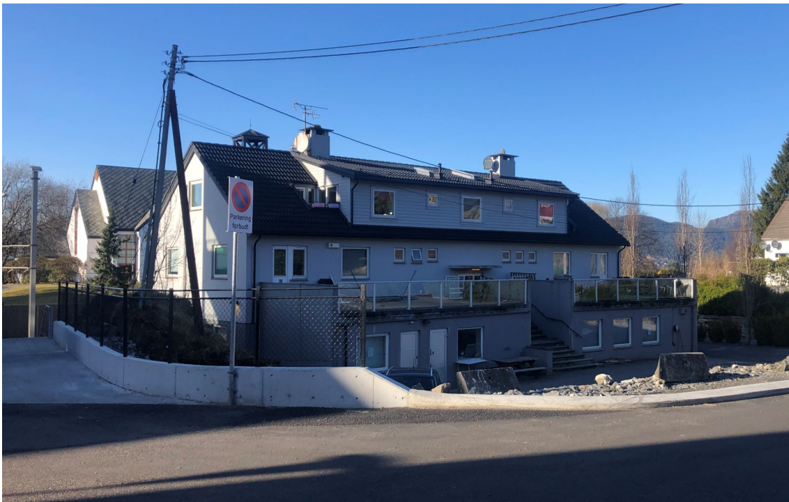
Figur 5-18 Sørøstre fasade. Foto: AKB, Opus.
