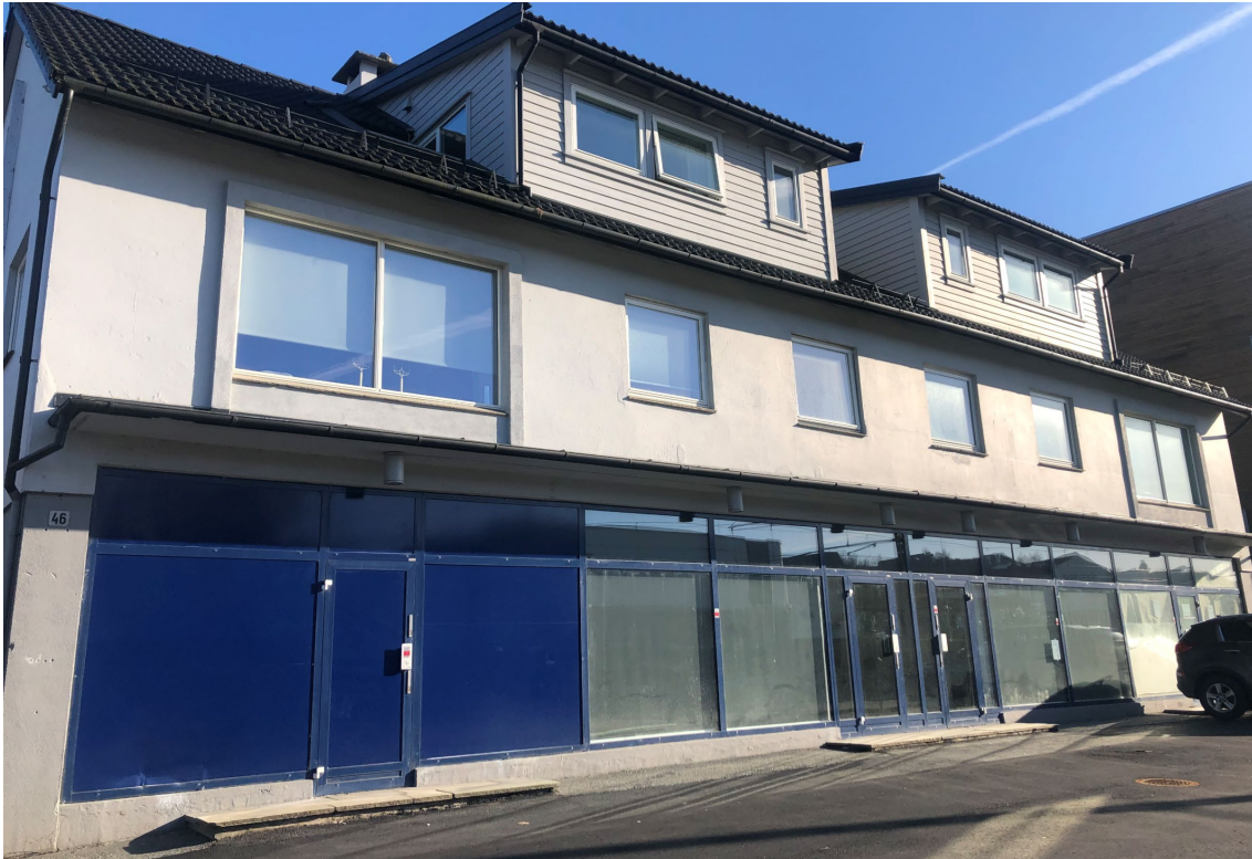
Figur 5-19 Nordøstre fasade. Foto: AKB, Opus.
