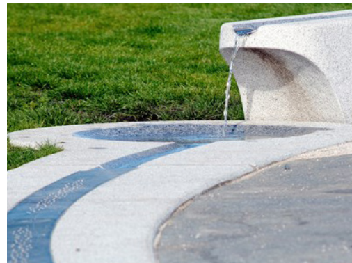
Estetisk håndtering av overvann
