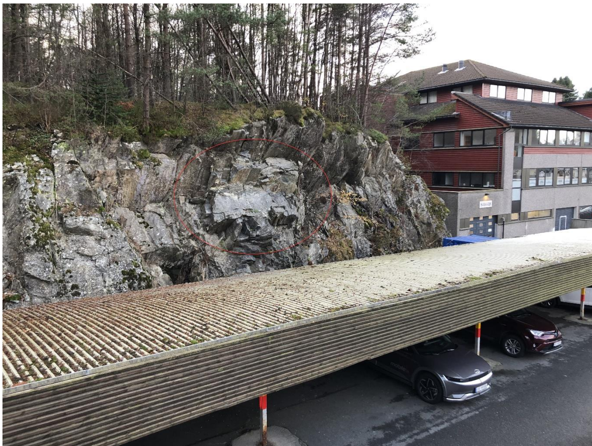
Figur 5. Usikret skjæring og avløste bergpartier (rød sirkel) lengst sør i kartleggingsområdet.
