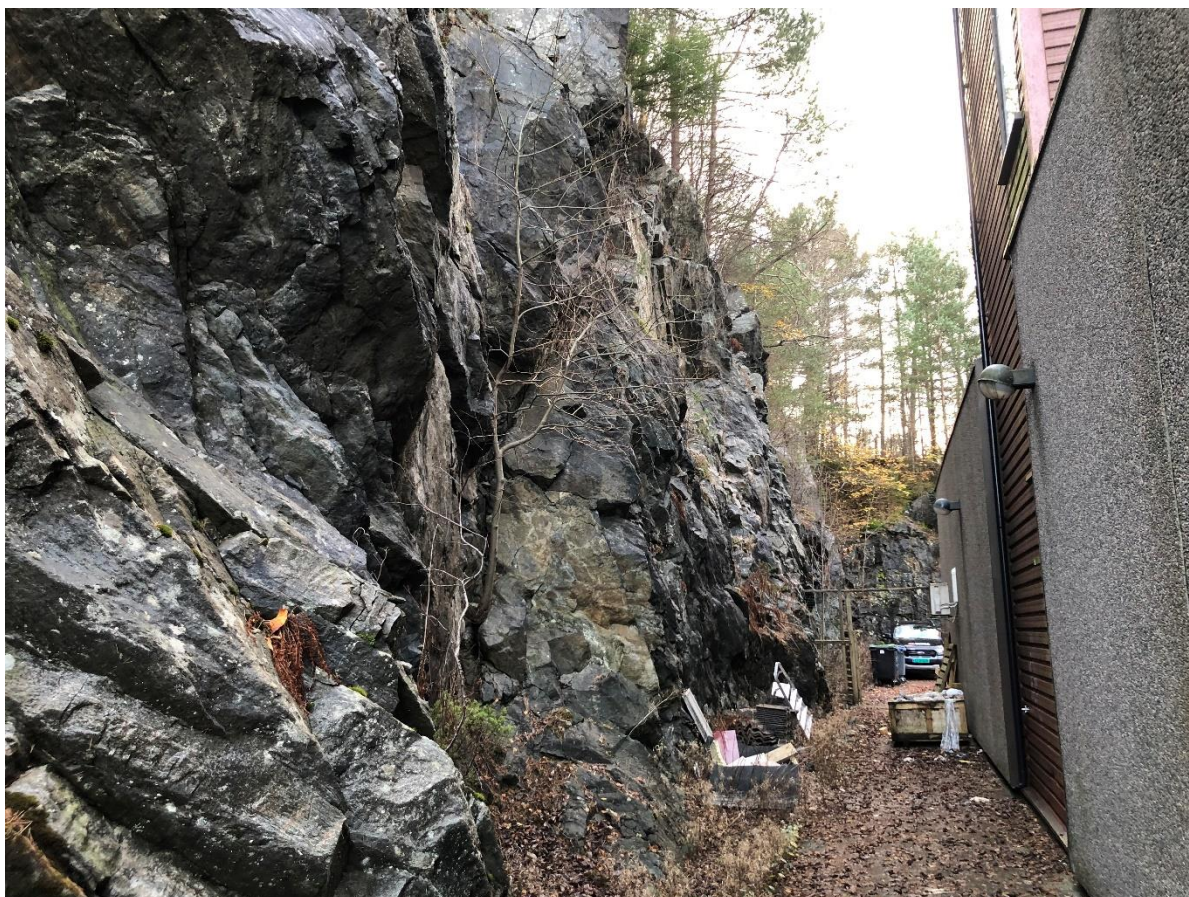
Figur 4. Usikret skjæring lengst sør i kartleggingsområdet.
