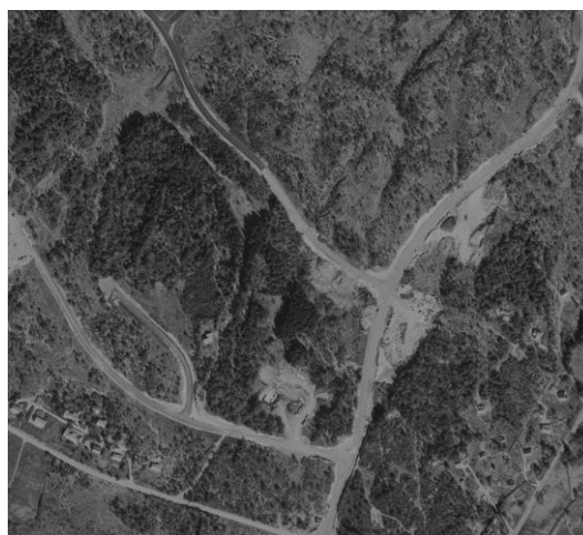
Figur 4: Flyfoto fra 1980 viser at området bygges ut med veier og flere områder er ryddet og planert.
