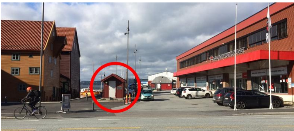
Figur 3-3030: Pumpehus for spillvann ligger midt i rommet mellom Fiskerimuseet og Neumann bygg.
