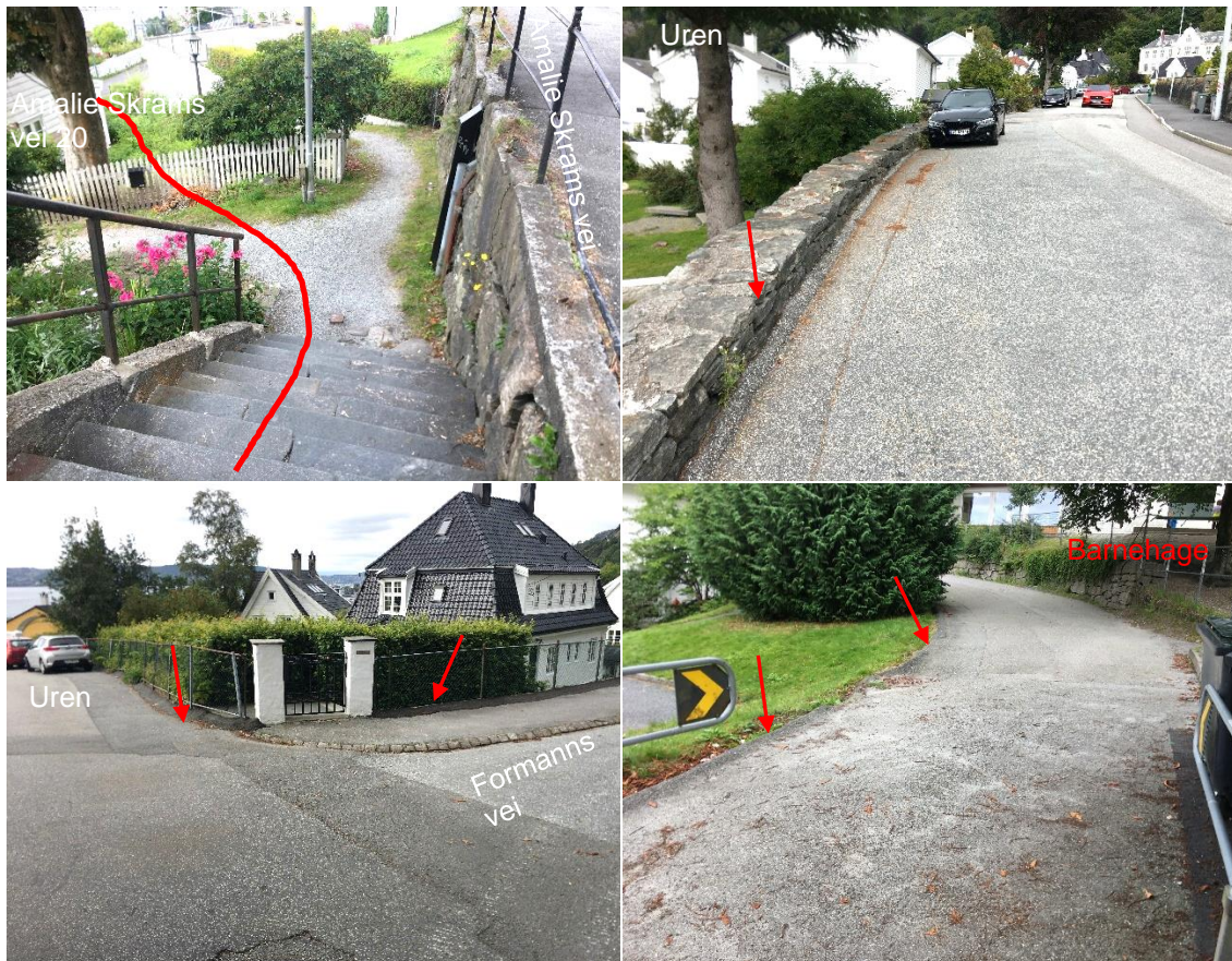
Figur 11 Oppe t.v. dagens avrenningsline fra Amalie Skrams vei ned gangveien forbi A. Skrams vei 20 og ned til Sandviksveien. Oppe t.h. er Uren hvor en liten steinmur fører overvannet langs gaten og ned til krysset med Amalie Skrams vei. Nede t.v. er krysset mellom Uren og Formanns vei. Asfaltkanter hindrer overvannet å renne inn på private eiendommer. Nede t.h. er gangstien forbi barnehagen ovenfor Uren. Asfaltkanter er etablert for å føre overvannet i gangstien ned til Uren.
