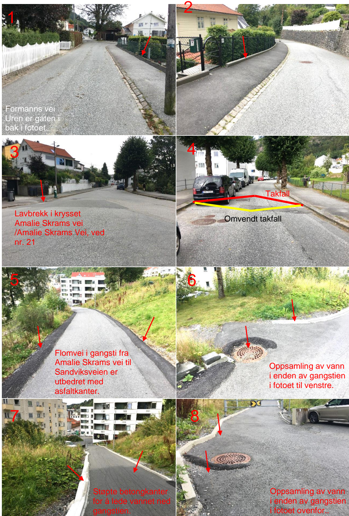
Figur 12 Foto 1 hvis hvor overvannet renner fra Uren og inn Formanns vei. Asfaltkanter langs Formanns vei hindrer overvannet i å renne inn på private eiendommer. Foto 2 viser asfaltkanter lenger nedstrøms i Formanns vei. Foto 3 viser lavbrekk i Amalie Skrams vei. Foto 4 viser hvordan Amalie Skrams vei kan etableres som flomvei ved å endre veigeometrien til omvendt takfall. Foto 5, 6, 7 og 8 viser gangstien fra Amalie Skrams vei og ned til Sandviksveien ved Gjensidigegården. Gangveien fører åpenbart mye overvann da det allerede er etablert asfaltkanter, støpekanter langs gangstien for å føre overvann, samt oppsamlingskanter for overvann ved slukene i gangstien.
