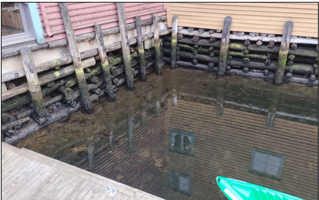
Figur 6: Bilete tatt i bakkant av bygget til Norges Fiskerimuseum viser finkorna avsetningar i botnsedimenta. Bygga er fundamentert på tømmerstokkar.
