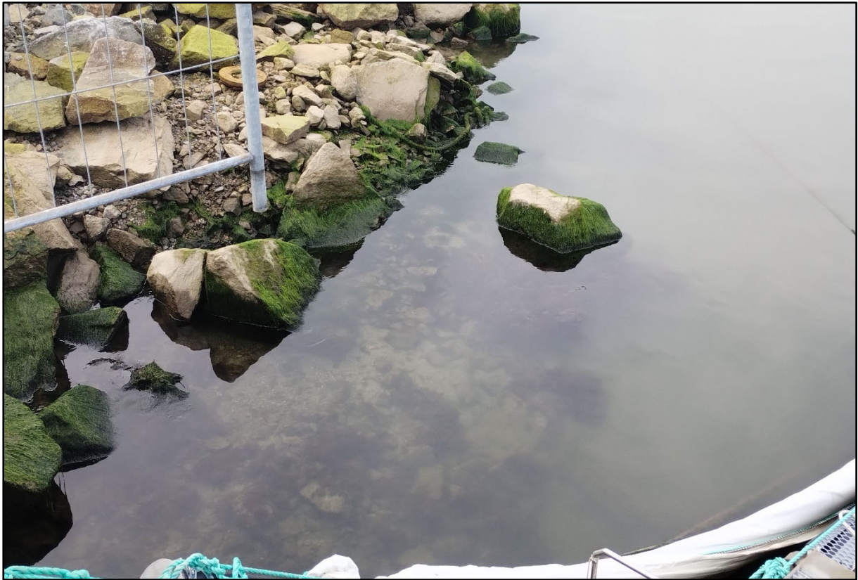
Figur 5: Storparten av strandlinja i det undersøkte området er utbygd av kaier og bygningar, slik at det er naturstein, betong og treverk som er eksponert mot sjøen. I mellom dette er det observert sediment bestående av fyllmassar, mudder og antatt silt og sand. Bilete tatt ved innde del av moloen som avgrensar hamna i sør.
