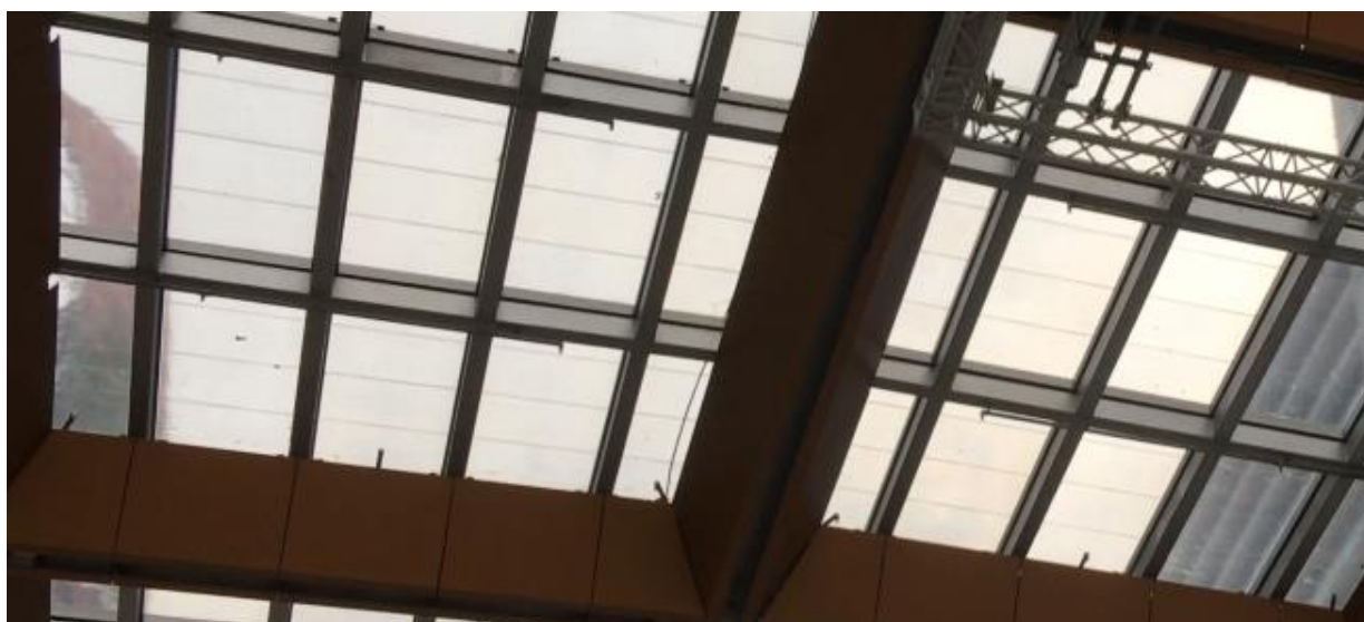
Figur 41: Amorphous Silicone skylight installasjon. Hentet fra Onyxsolar.com
