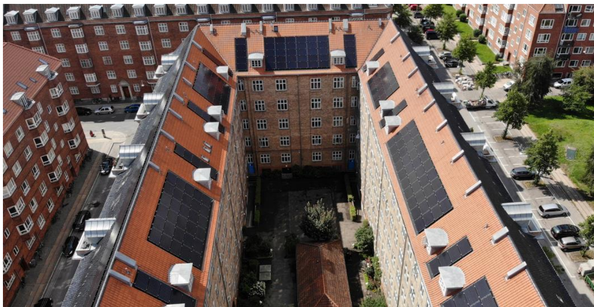
Figur 43: Standard solcellepaneler installert på skråtak. Foto: COWI.
