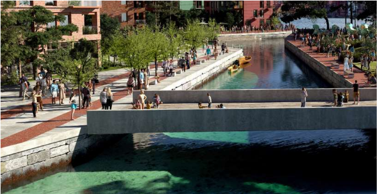
Figur 3-3: Utsnitt fra formingsveileder som viser murfront av naturstein langs kanal.
