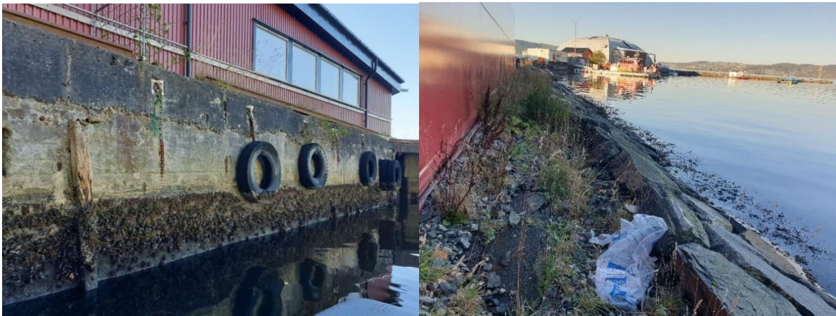
Figur 4. Delområde 1. T.v.: Loddrette kaikanter stupte rett i sjøen og ned til 3-5 m dyp. Bildet er fra Delområde 1, østre del. T.h.: skrånende steinfylling ut i sjøen på vestlig del av delområdet. Foto: Odin Kirkemoen 14.10.2020.
