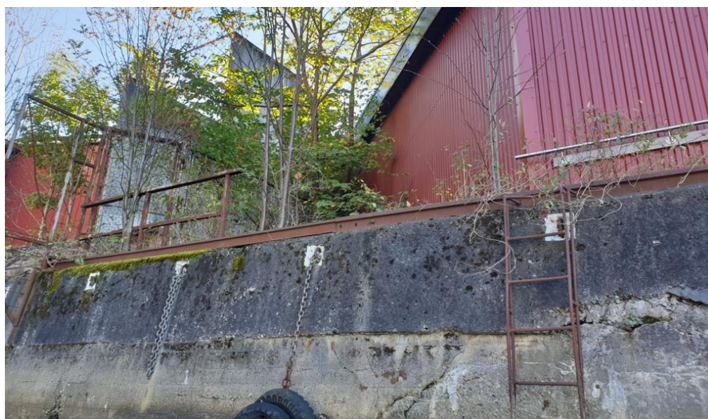
Figur 1. Bratte bryggekanter og småvokst trevegetasjon uten nevneverdig verdi. Foto: Odin Kirkemoen 14.10.2020.
