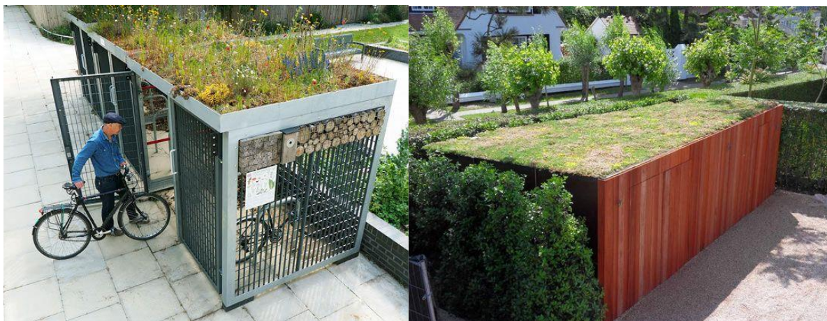
Figur 16-1: Eksempler på utvendig overdekket sykkelparkering.
